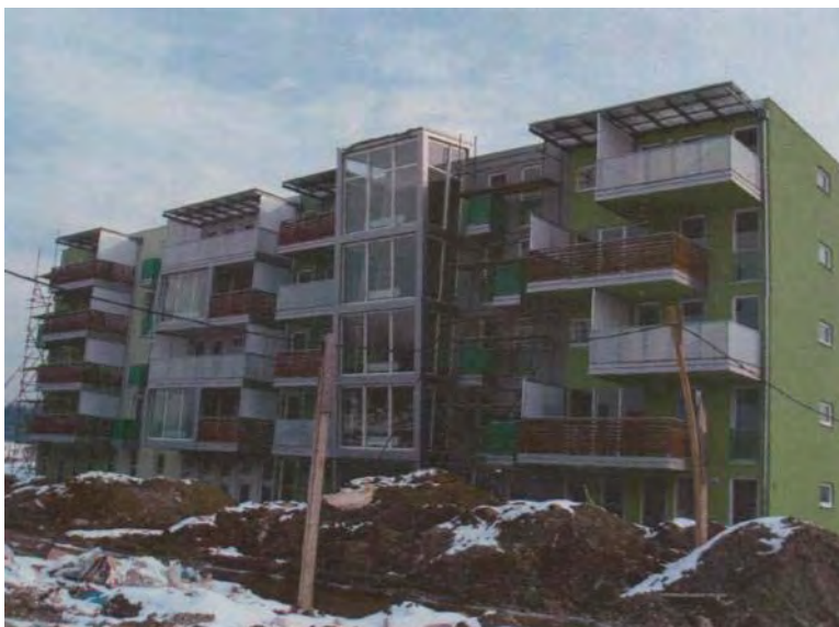
Najnovejši bloki v Novi vasi - v gradnji
