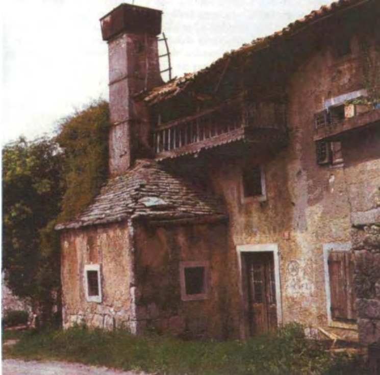
Primer spahnjenice z gankom na Krasu
