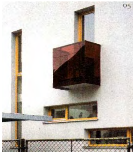
Moderni balkon z barvno PVC ograjo
