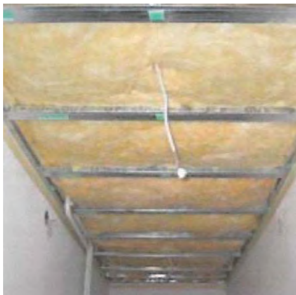
Slika 3 - prikaz izolacije stropa
