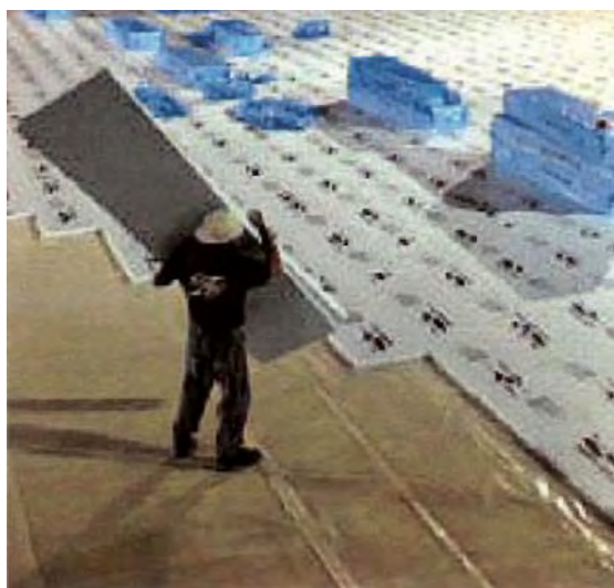
Slika 7 - toplotna izolacija tal
