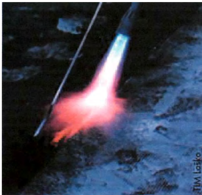
Slika 2 - prikaz pritrditve bitumenske lepenke
