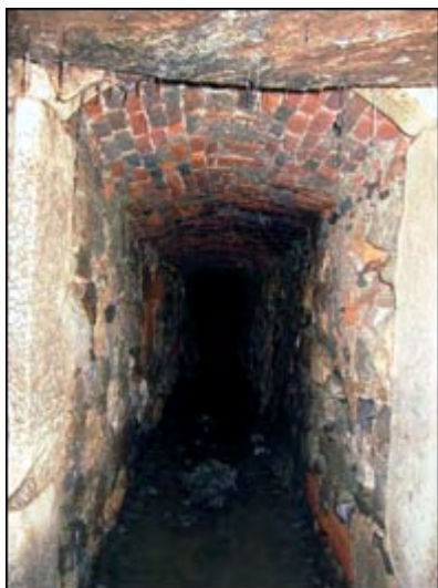
Slika 4: Delno obnovljeni rimski kanal v funkciji še danes
