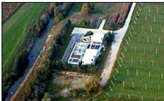
Slika 14: Čistilna naprava Škofja vas
