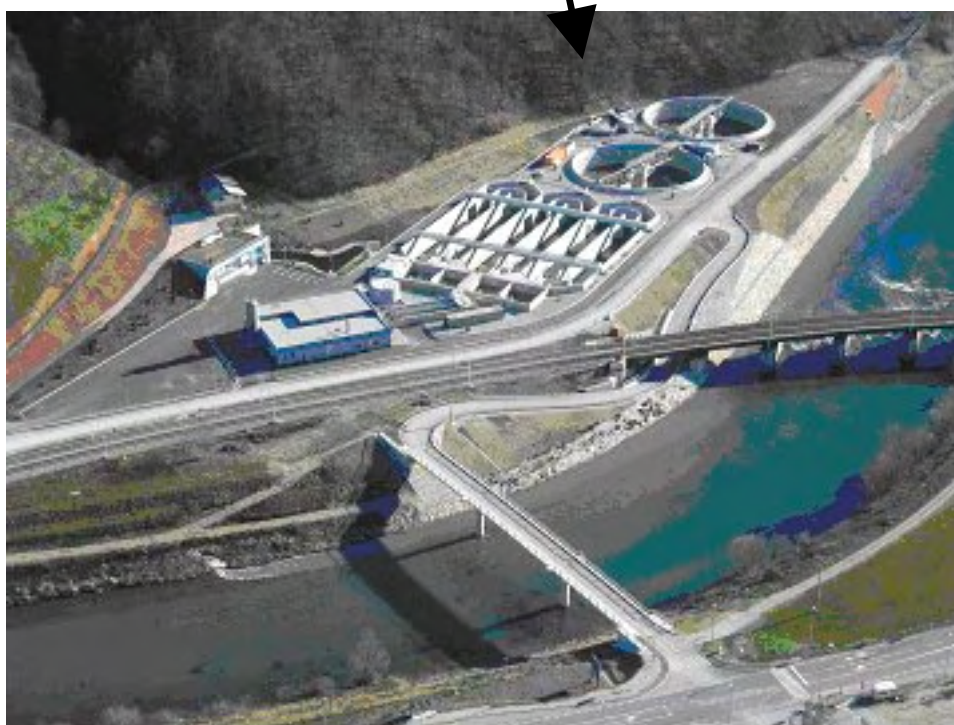
Slika 13: Čistilna naprava Celje
