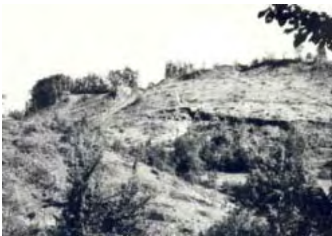
Slika: Drsenje zemlje zaradi izkopavanja premoga. (Vir: Franc Napret)
