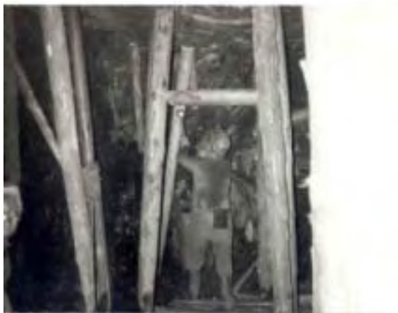
Slika - Podpiranje stropa z lesnim podporjem v odkopu premoga.
