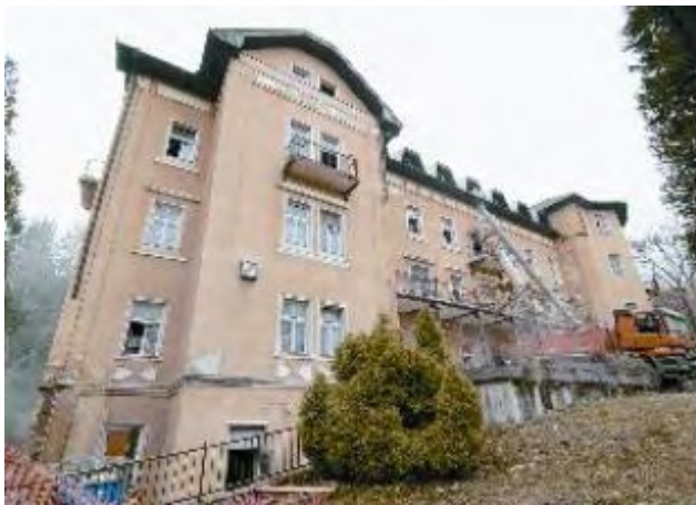
Slika 16: Pričetek obnove Sofijinega dvora
