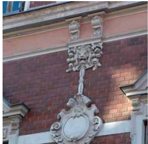
Slika 8. Štukatura na Stanetovi ulici.
