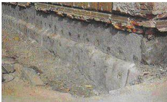
Izvedba horizontalne hidroizolacije kamnitega hišnega podstavka z vbrizgavanjem vodoodbojne neomočljive snovi
