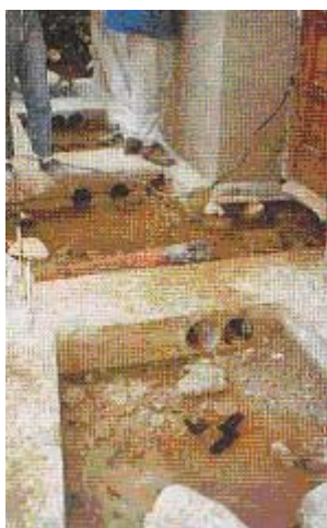
Zaščita utrjenega dela kletnega zidu hišnega podstavka z vertikalno hidroizolacijo, izvedena z bitumensko maso
