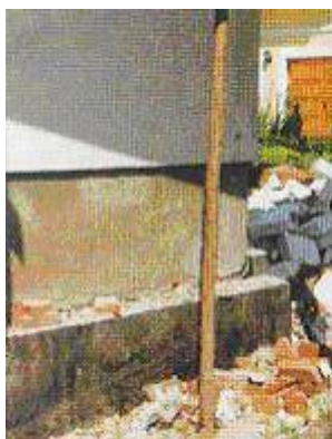
Zaščita utrjenega dela kletnega zidu hišnega podstavka z vertikalno hidroizolacijo, izvedena z bitumensko maso
