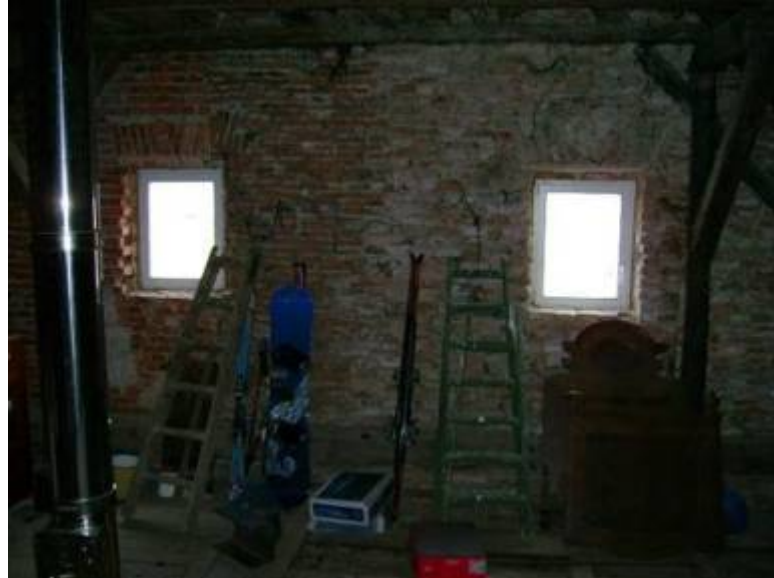
Slika 30: Zid na podstrešju
