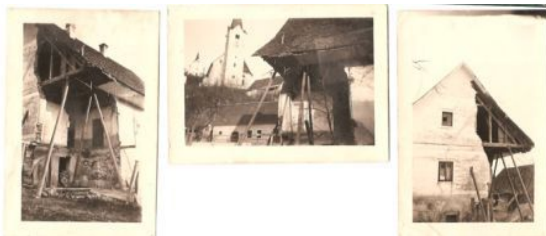
Slika 13: Bomba je uničila del hiše
