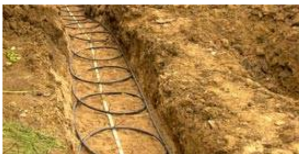
Slika 34: Polaganje zemeljskega kolektorja
