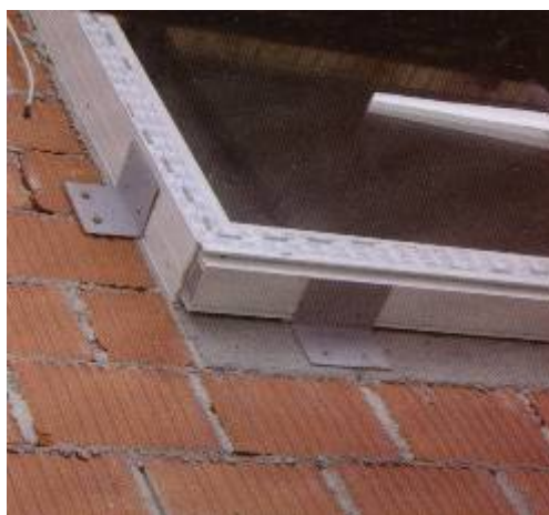
Slika 12: montaža okna na masiven zid: vgrajena na konzole v liniji toplotne zaščite, potem tesnenje z elastičnim trakom, nato se vgradi fasadna toplotna zaščita (20-25cm)
