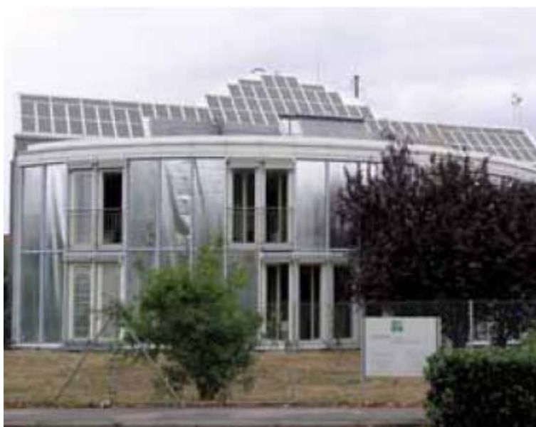
Slika 6: Orientacija proti jugu in krožna zasnova zgradbe omogočata izrabo sončne energije z uporabo zastekljenih površin, prosojne toplotne izolacije, sprejemnika sončne energije in sončnih celic, energijsko samozadostna hiša.
