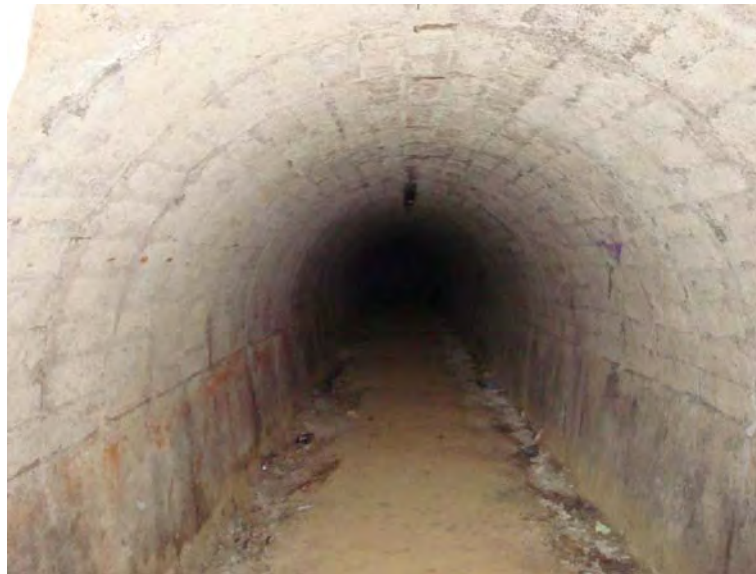
Slika 1 : Notranjost zakloniščnega rova pod Golovcem
