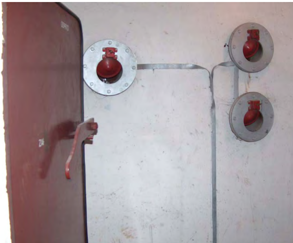
Slika 7: Zračniki stanovanjskega zaklonišča na Ulici frankolovskih žrtev
