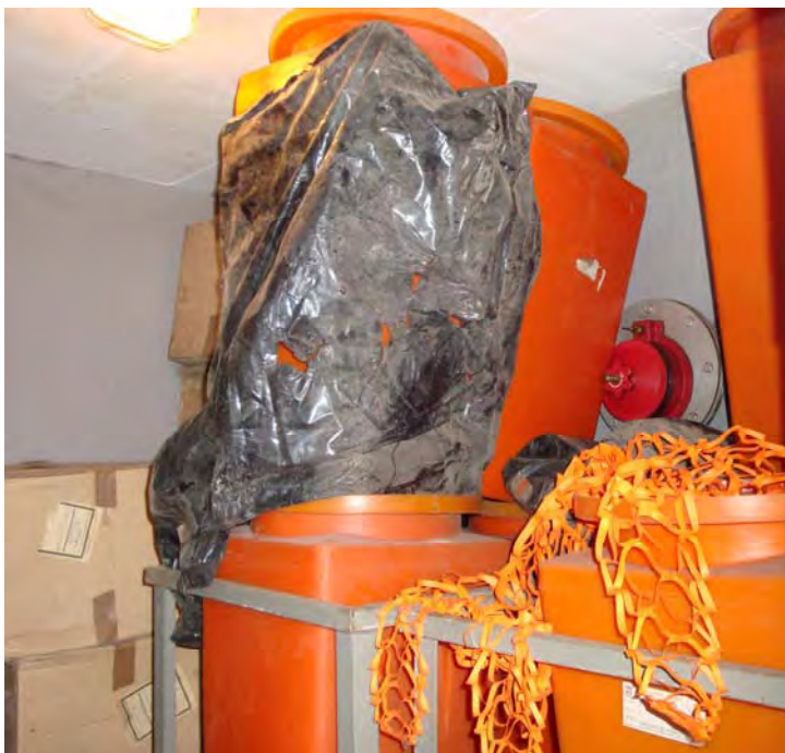
Slika 22: Zaklonišče na Vrunčevi ulici - oprema zaklonišč je predpisana
