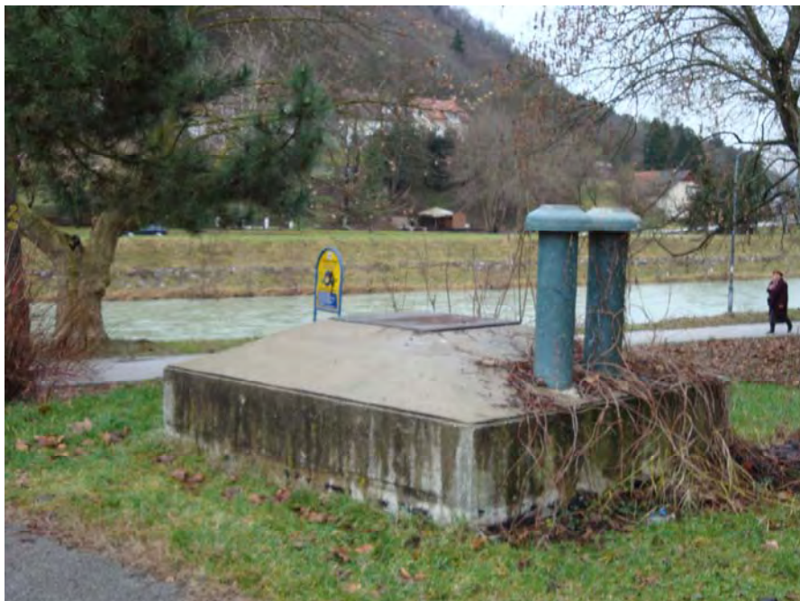
Slika 2: Zasilni izhod in zračniki zaklonišča na Trubarjevi 53
