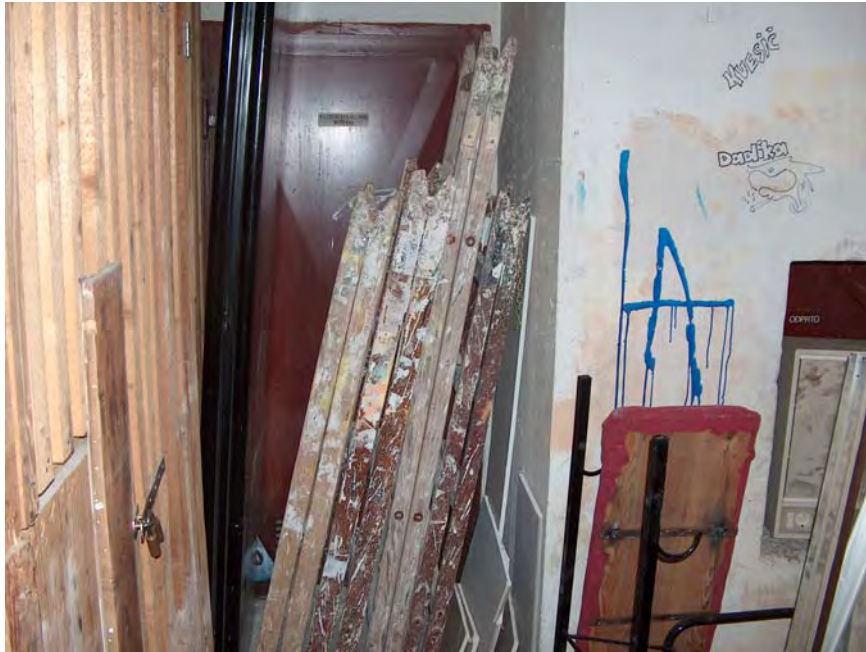
Slika 5: Zatrpan zasilni izhod iz stanovanjskega zaklonišča
