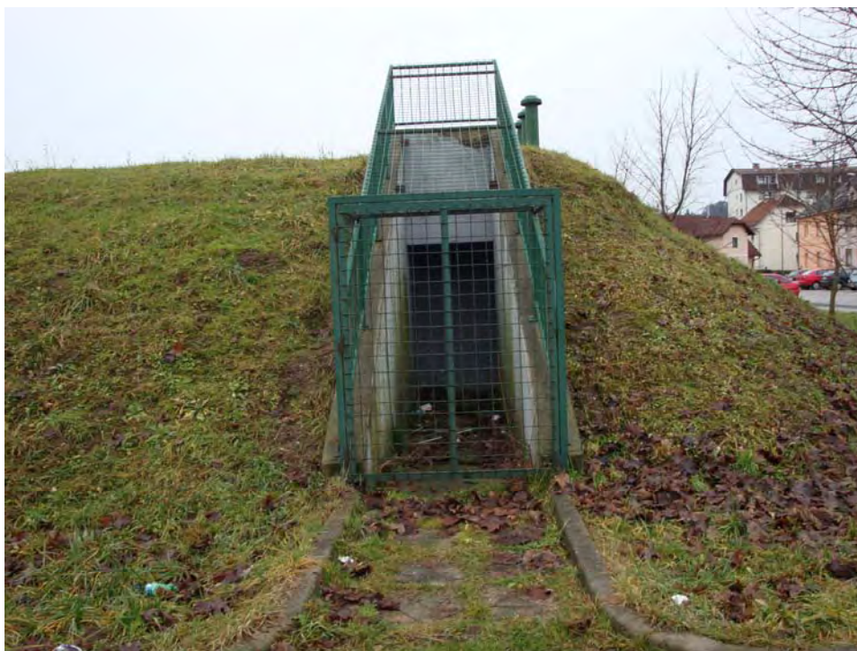
Slika 8: Zaščitena vhodna vrata v zaklonišče na Vruncjevi ulici pri sejmišču
