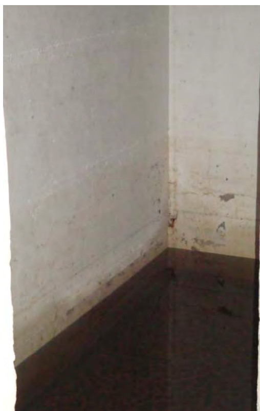
Slika 10 : Poplavljeno zaklonišče na Trubarjevi 53
