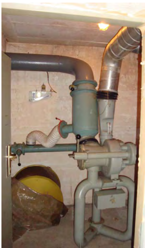
Slika 9: Prezračevalni sistem v zaklonišču na Vrunčevi ulici v Celju
