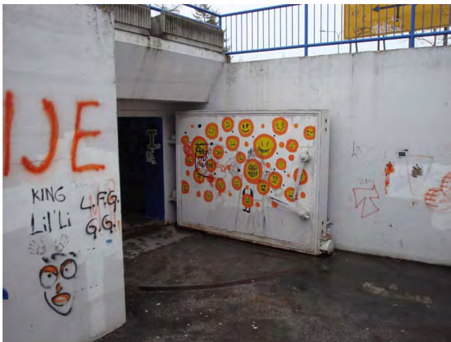
Slika 6 : Vhod v podhod pod obvoznico na Vrunčevi ulici se lahko zapre z masivnimi vrati
