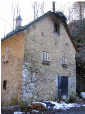
Slika 94: Šentjanž nad Štorami, Horjak
