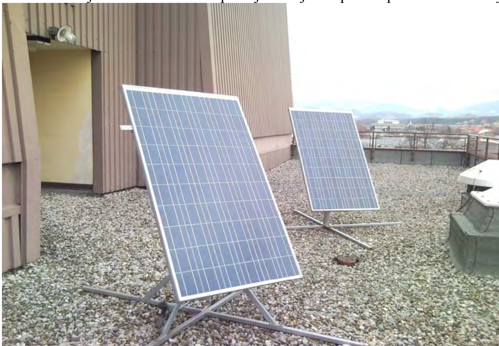
Slika 4: Fotovoltaična modula s kraki za stabilnost
