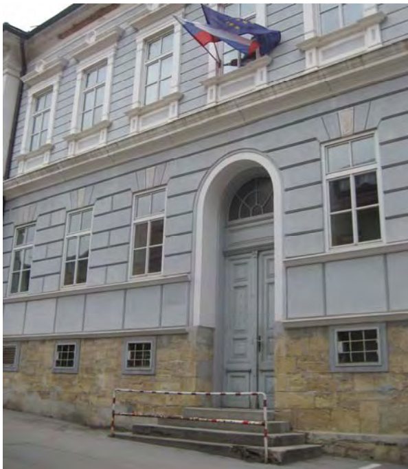
Slika 3: Vhod v nekdanjo šolo
