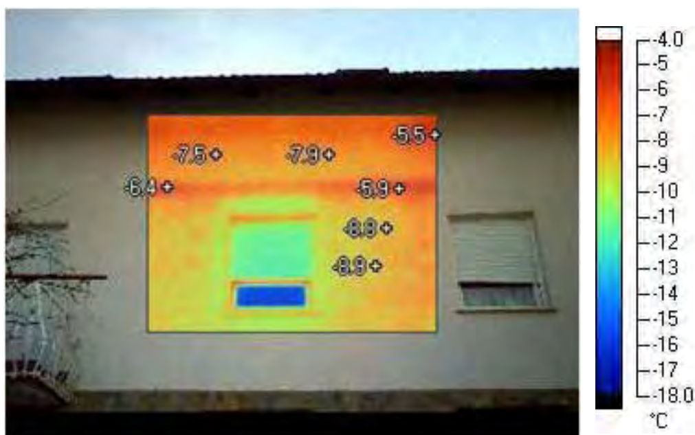
Slika 19: Severna stena objekta B
