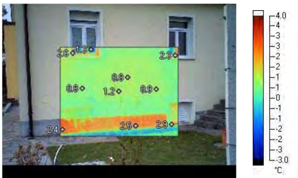
Slika 8: Severna stena objekta A
