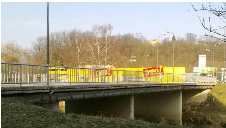
Slika 10 - Most preko Teharske ceste (Most Pocajtov mlin) (Foto: Špela Ocvirk)
