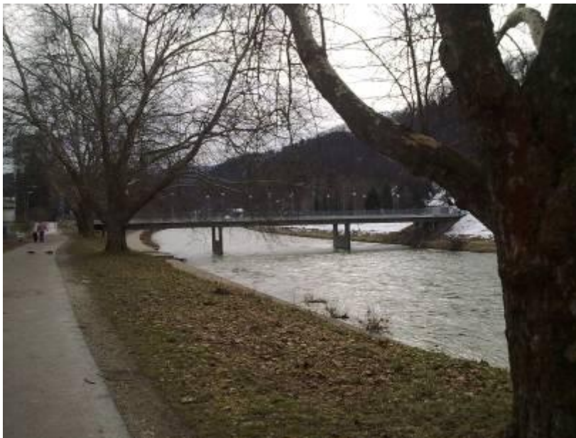
Slika 4 – Čopov most (Foto: Špela Ocvirk)
