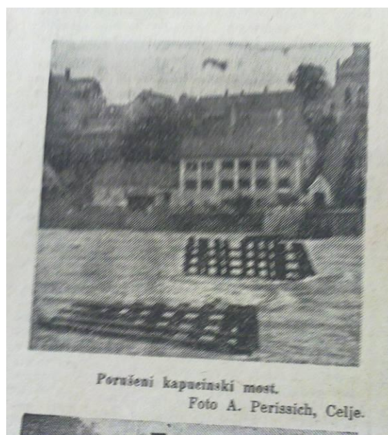
Slika 1 - Porušen Kapucinski most (vir: Zgodovinski arhiv Celje)
