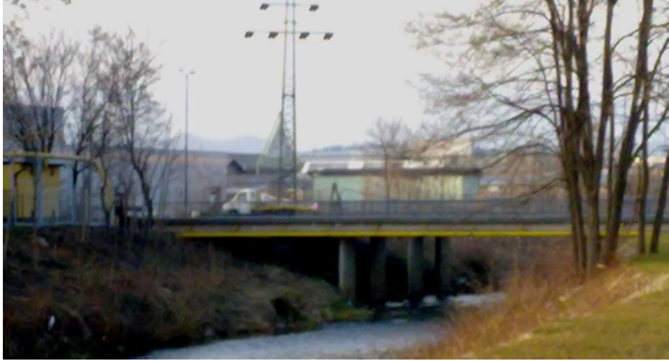
Slika 13 - Most na Kidričevi ulici (Foto: Špela Ocvirk)
