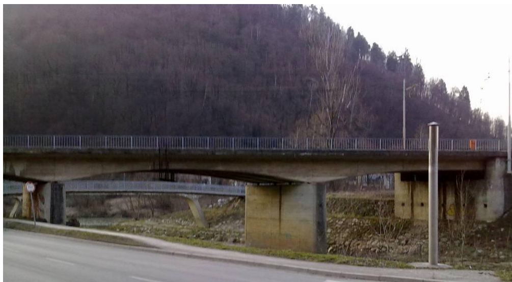
Slika 12 - Železniški most čez Voglajno (Foto: Špela Ocvirk)
