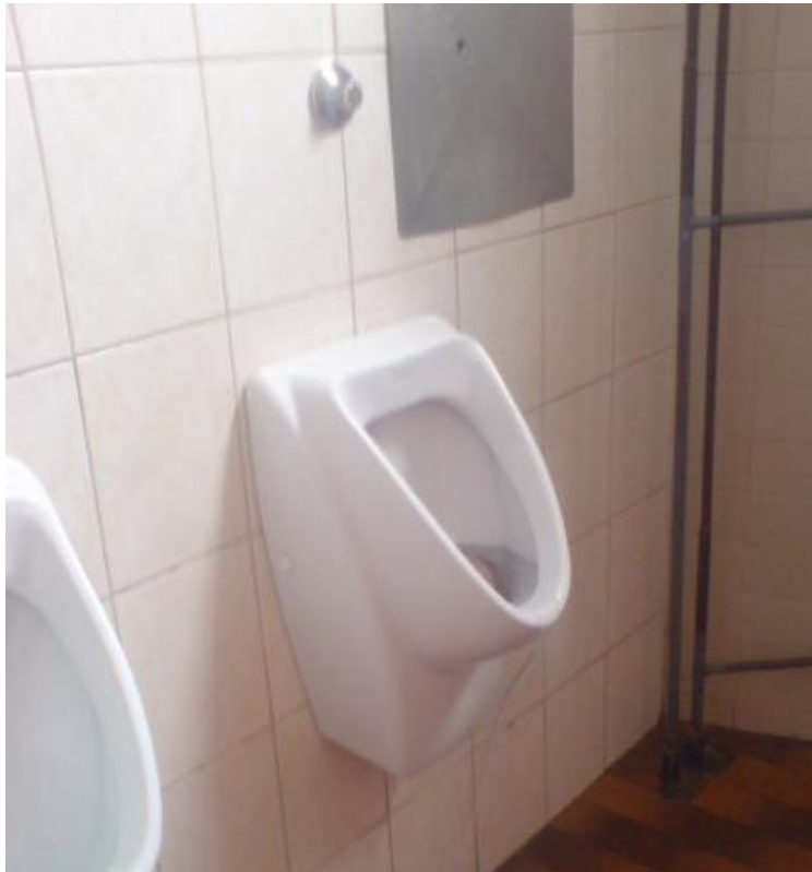
Slika 36: Iztekanje vode na pisoarju
