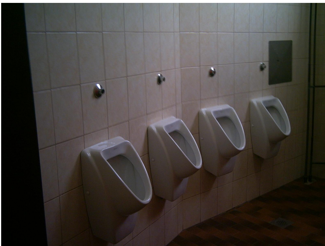
Slika 35: Pisoarji - vezani in senzorji
