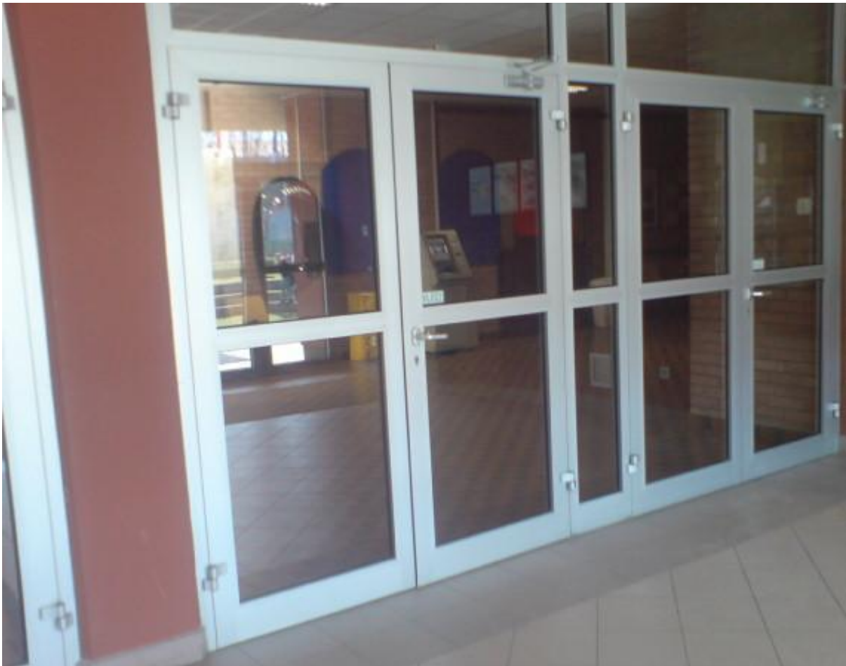
Slika 41: Vhodna vrata na Šolskem centru Celje z mehanizmom za samodejno zapiranje
