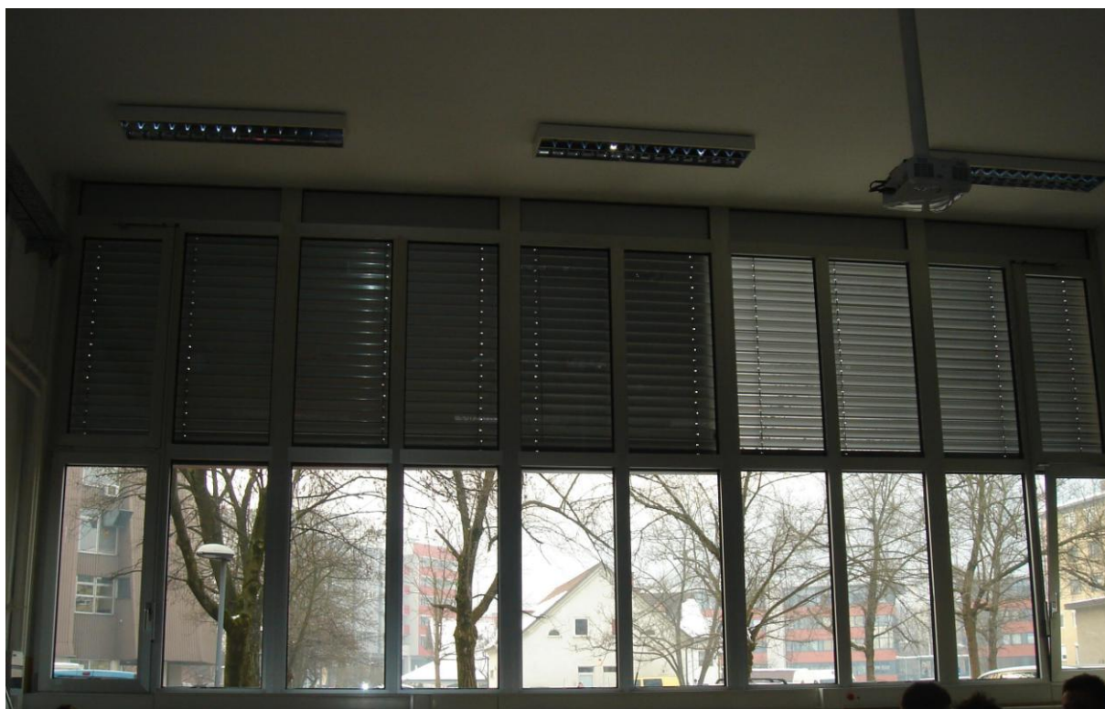
Slika 40: Nova okna v obnovljeni učilnici A-41
