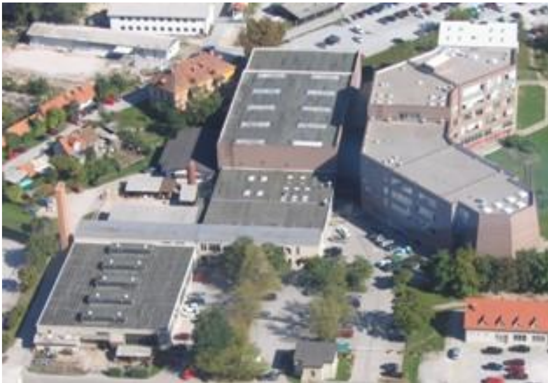
Slika 52: Šolski center Celje z neizkoriščeno površino strehe
