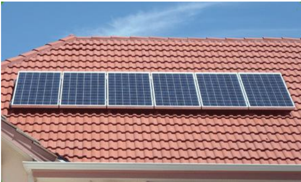
Slika 46: Postavitvev sončne elektrarne na strehi
