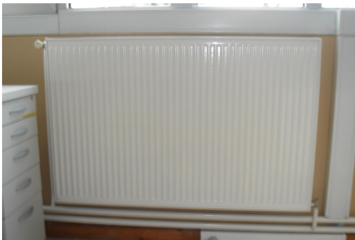
Slika 32: Radiator v obnovljeni učilnici A-41
