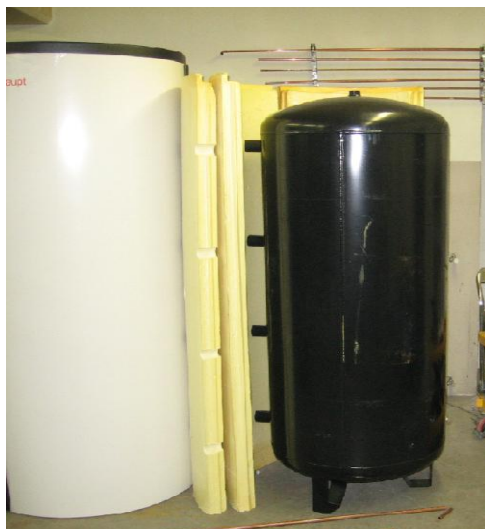
Slika 37: Hranilnika Weishaupt in Puffer
