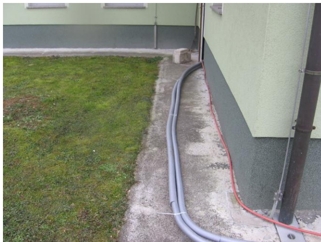
Slika 48: Povezava do kolektorjev
