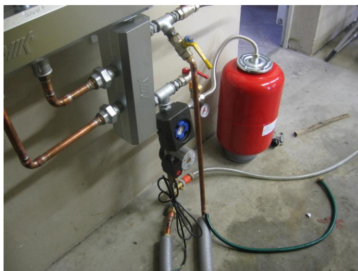
Slika 47: Navezava dovoda in povratka iz kolektorjev
