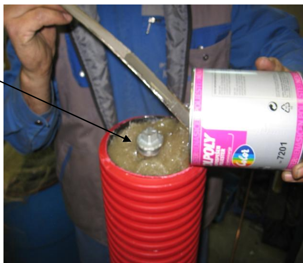
Slika 30: Tesnjenje s poliestrsko maso
