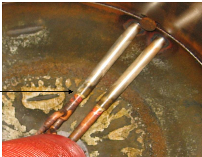
Slika 31: Prehod iz bakrene cevi na nerjavno
