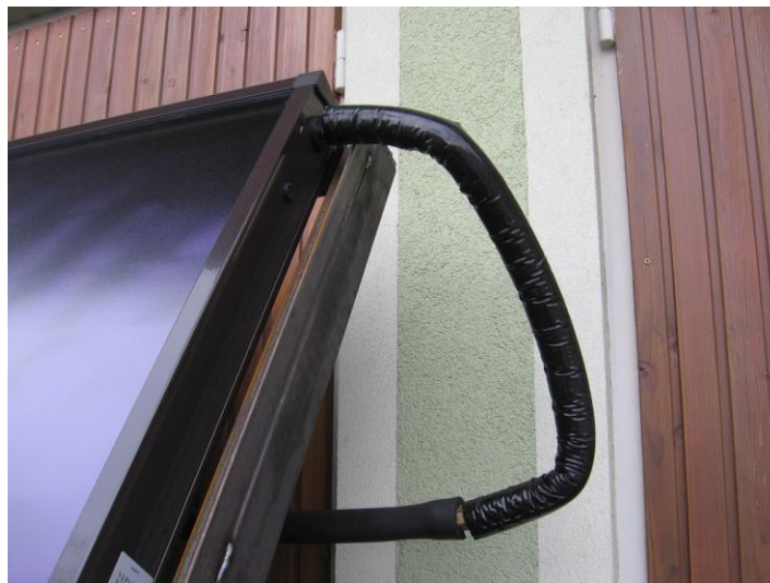
Slika 46: Fleksibilna cev na izhodu iz kolektorja
