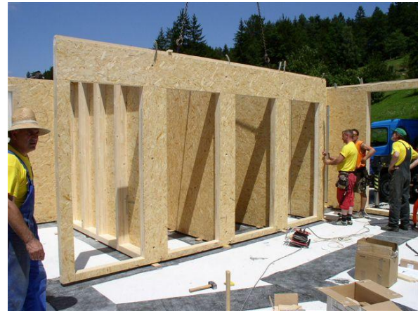
Slika 36: Pritrjevanje notranjega nosilnega zidu
