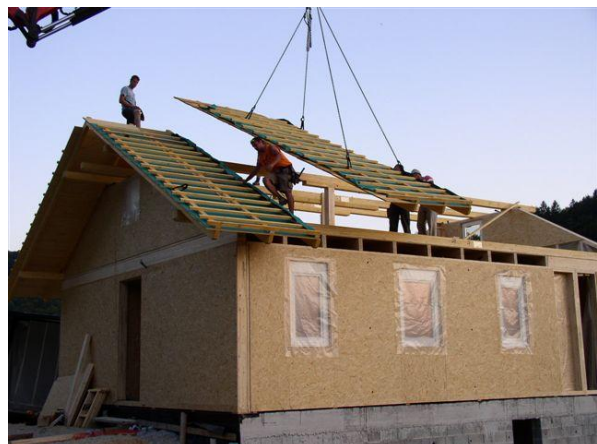
Slika 50: Postavitev naslednjega strešnega elementa
