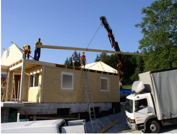
Slika 45: Postavljanje kapnih leg
