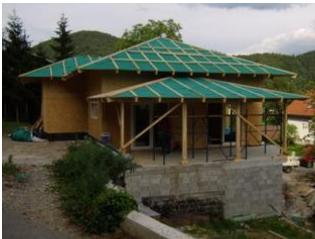
Slika 2: Hiša med potekom gradnje
