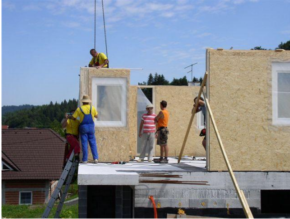
Slika 33: Vijačenje še zadnjih zunanjih elementov
