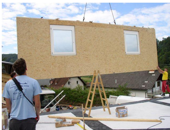
Slika 26: Postavljanje zidu na že izdelano ploščo
