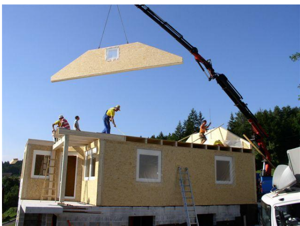
Slika 43: Prenos mansardnega elementa
