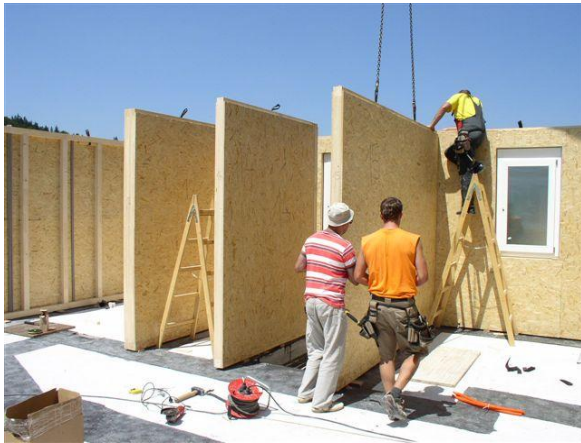
Slika 35: Postavljanje predelnih sten
