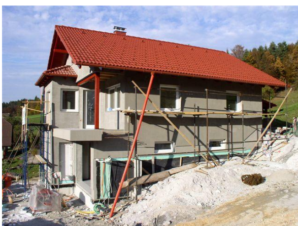
Slika 59: Zaključna dela ometov
