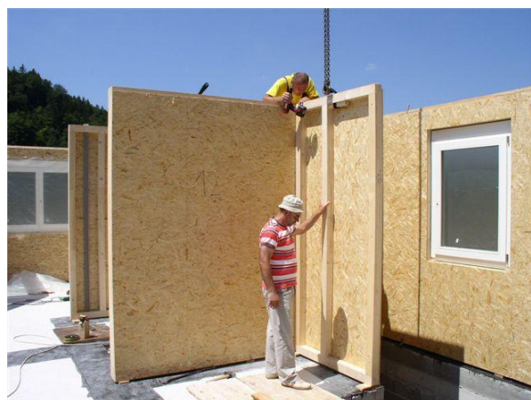
Slika 38: Še zadnja vgrajena predelna stena
