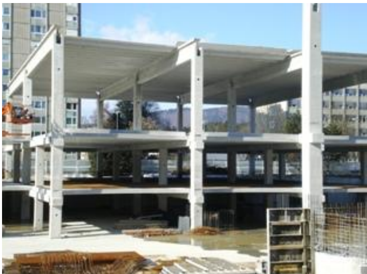
Slika 11: Gradnja trgovskega centra
