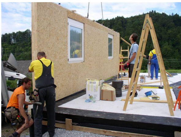
Slika 27: Postavljanje zidu v pravilno lego
