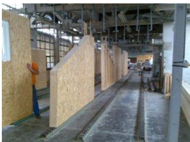
Slika 19: Izdelava zidov v proizvodnji
