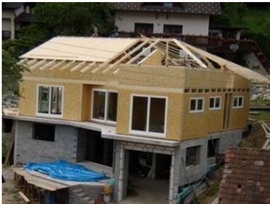
Slika 18: Prikaz gradnje montažne hiše na že obstoječo pritlično etažo
