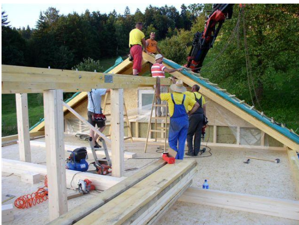
Slika 49: Vijačenje strešnega elementa
