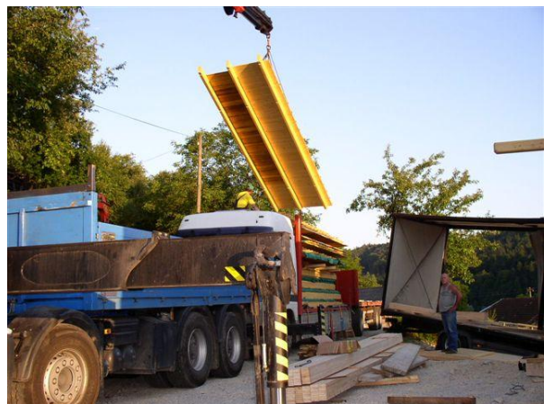
Slika 48: Prenos strešnega elementa
