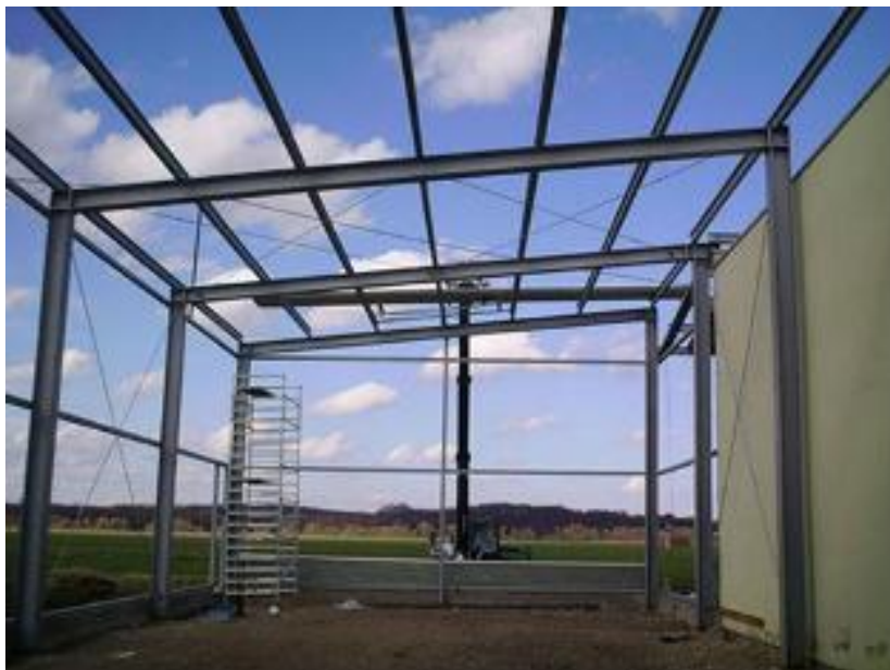
Slika 6: Gradnja z jeklenimi I-profilii
