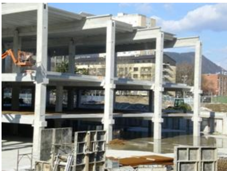
Slika 12: Gradnja z betonskimi stebri in ploščami
