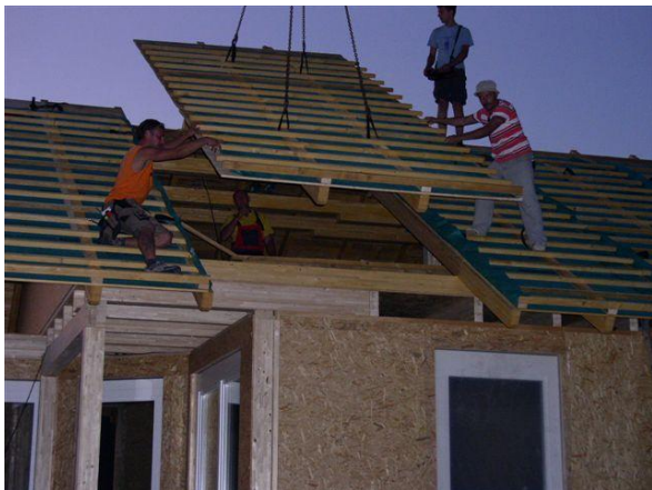
Slika 51: Postavitev še zadnje plošče strešne konstrukcije
