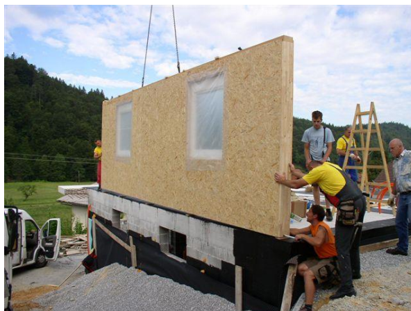
Slika 28: Fiksiranje zidu na ploščo
