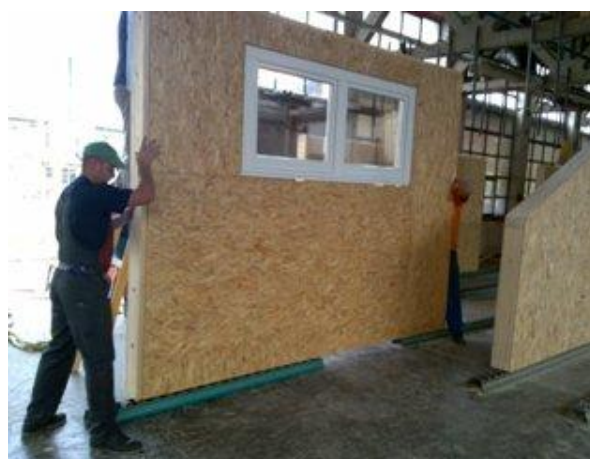
Slika 20: Izdelan zid z vgrajenim oknom
