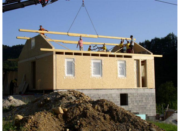
Slika 46: Postavljanje vmesnih leg
