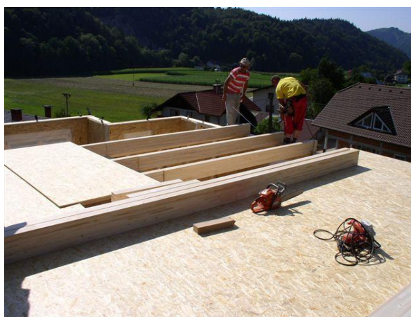
Slika 42: Postavljanje OSB plošč preko tramov
