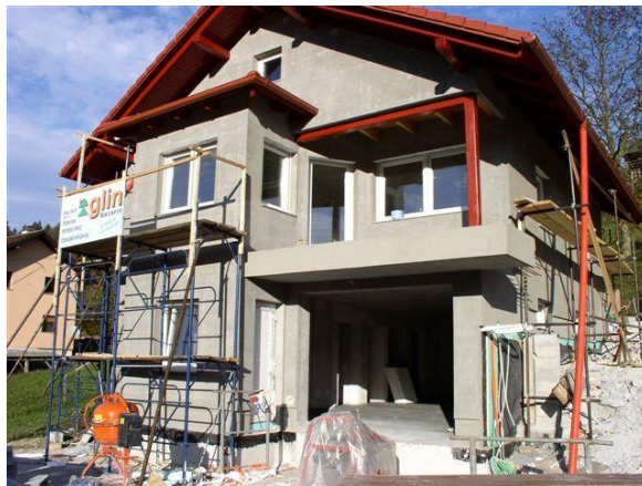
Slika 58: Izdelava ometov
