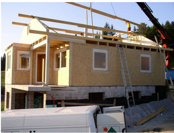
Slika 47: Postavljanje slemenskih leg
