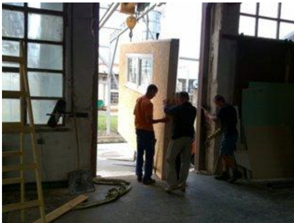
Slika 21: Zid pripravljen za transport
