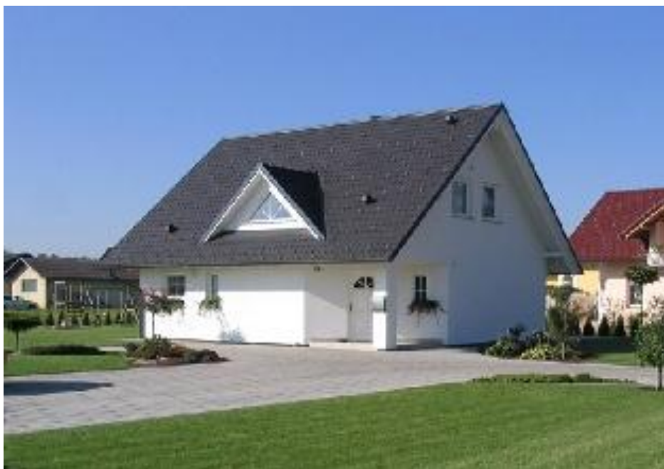
Slika 1: Montažna hiša z urejeno okolico
