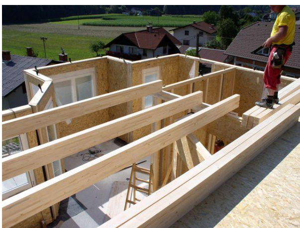
Slika 41: Vijačenje tramov na spodnje zidove
