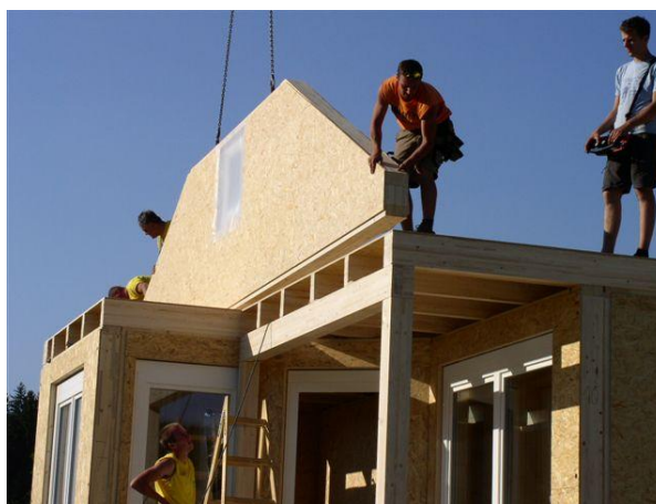
Slika 44: Nameščanje mansardnega elementa
