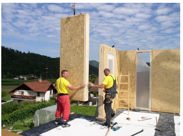
Slika 31: Postavljanje naslednjega elementa
