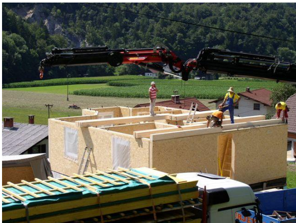
Slika 39: Priprava na postavitev tramov
