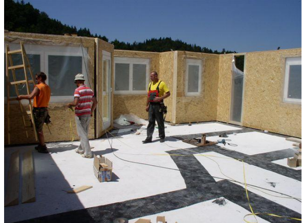
Slika 34: Ojačitev zunanjih zidov
