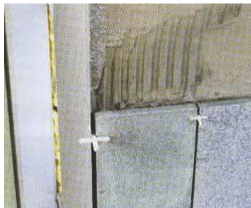
Slika 30; Prikaz izdelave kamnite fasade
