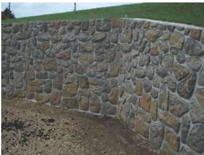
Slika 36: Kamniti oporni zid
