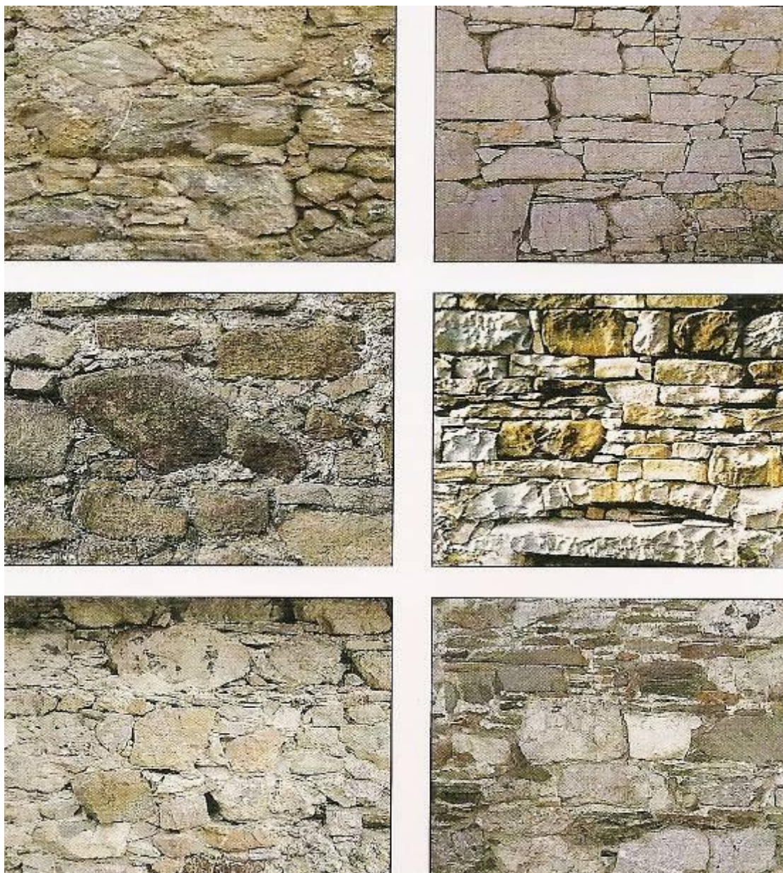
Slika 26; Stene iz grobo obdelanih lomljencev v nepravilno zgrajeni in pravilno slojevito zložen kamen
