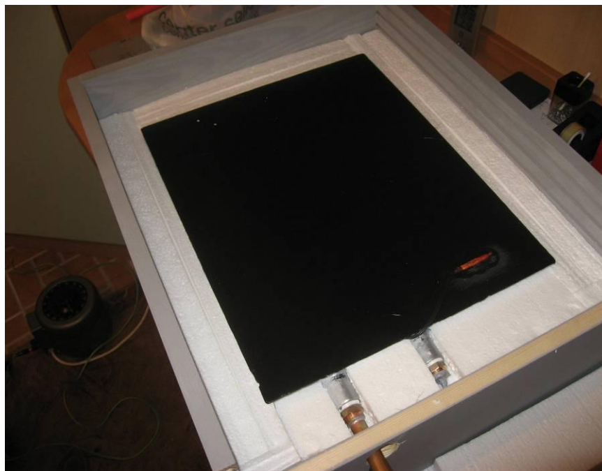
Slika 29: Nameščanje in izolacija kolektorja II, ki je sestavljen kar kot toplotni zbiralnik Oba kolektorja in zbiralnik, so razen z obsevalne strani, kjer lahko nameščeno enojno ali dvojno steklo, v celoti izolirano z 6 cm oblogo stiropora, da se zmanjša vpliv izgub toplote.
