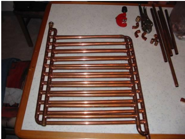
Slika 23: Sestavljen del kolektorja
