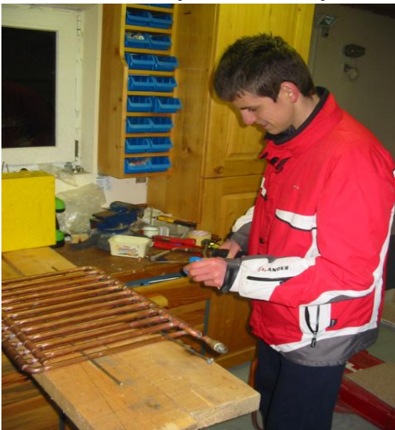
Slika 25: Lotanje- varjenje kolektorja
