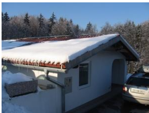
Slika 10: Vhod v zavetišče in hotel Zonzani
