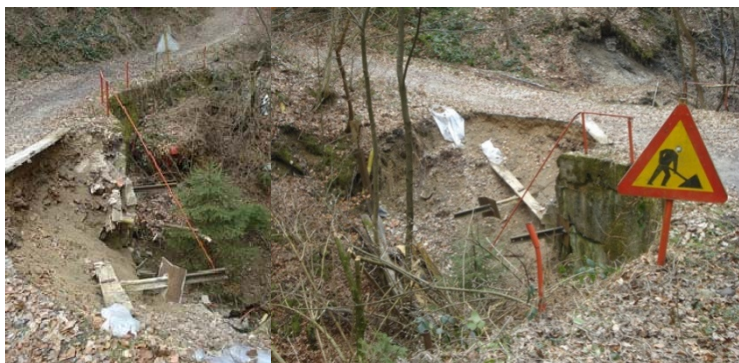
Slika 29: Porušen most v Liscah Foto: Ž. Benčina, 2011
