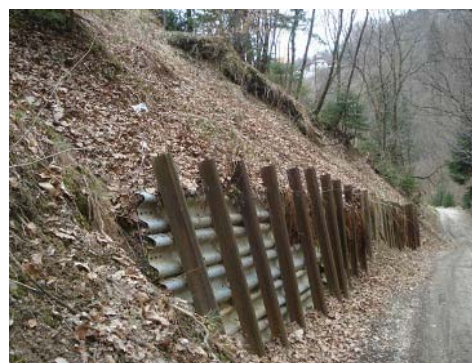
Slika 42: Delna sanacija v Liscah Foto: Ž. Benčina
