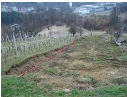
Slika 34: Urejene drenažne cevi v Vrheh Foto: Ž. Benčina, 2011
