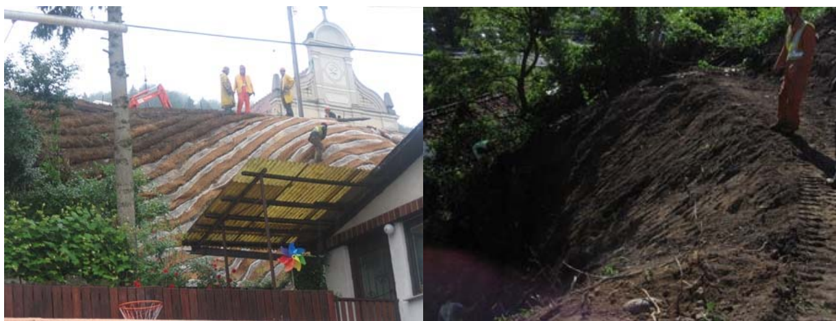
Slika 36: Saniranje plazu na Bregu Vir: Arhiv MOC, 2010
