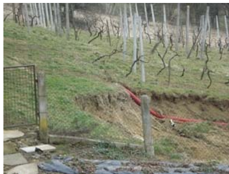
Slika 23: Urejene drenažne cevi Vir: Arhiv MOC, 2010
