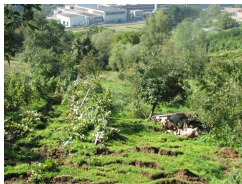
Slika 33: Škoda po plazu Vrhe Vir: Arhiv MOC, 2010
