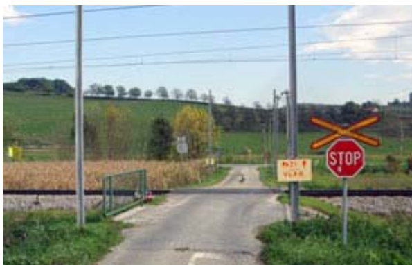
Slika4: Nezavrovan železniški prehod z Andrejevim križem in stop znakom
