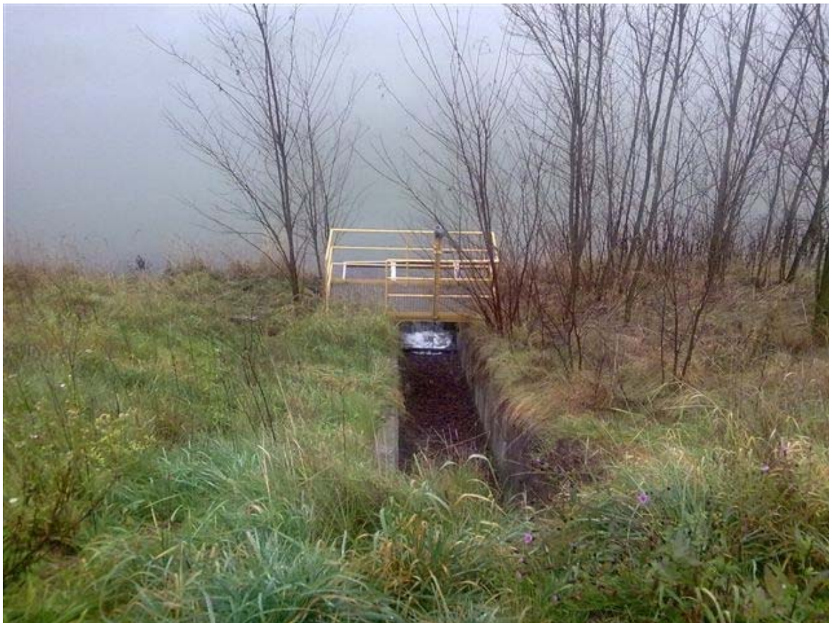
Slika 4: Urejen preliv odpadnih vod iz odlagališča sadre
