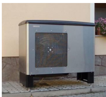
Slika 24: Toplotna črpalka na zrak
