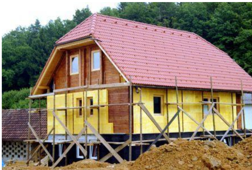
Slika 6: Primer oblaganja objekta s toplotno izolacijo
