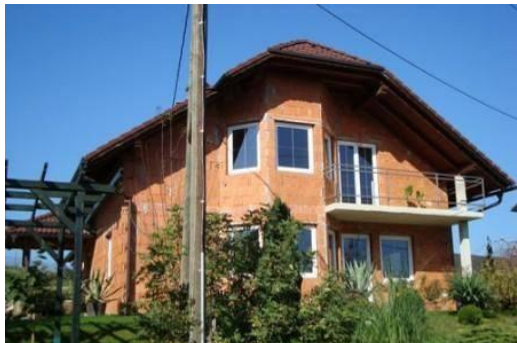
Slika 39: hiša po prenovi fasade
