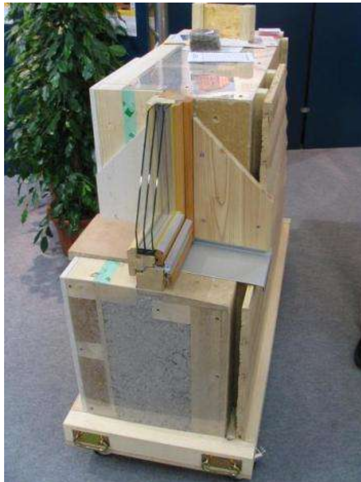
Slika 12: detajl vgradnje oken
