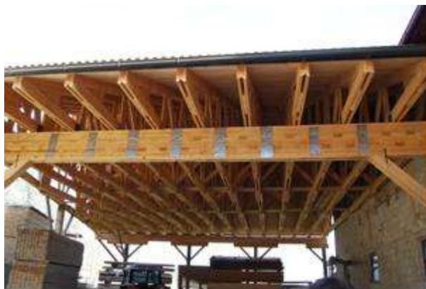
Žebljana konstrukcija ostrešja.
