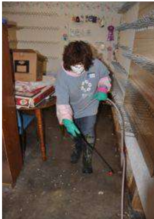
Čiščenje in dezinficiranje poplavljenih prostorov.
