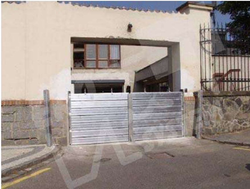
Zaščita dvorišča pred poplavo.
