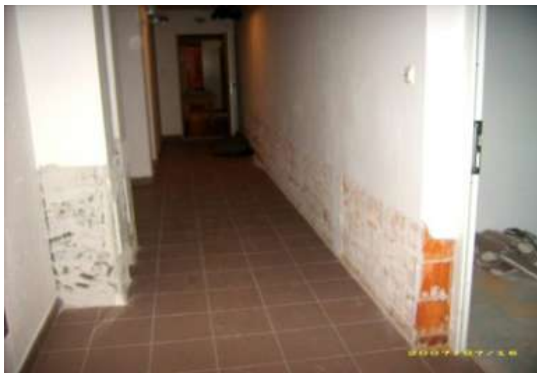
Odstranjen poškodovan omet.
