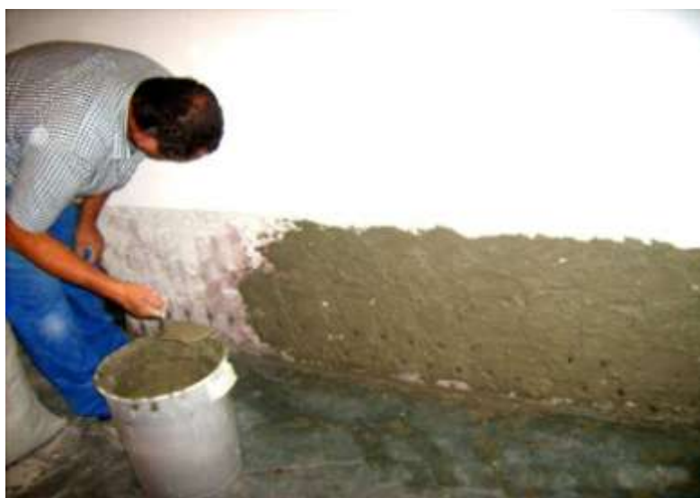
Izdelava sušilnih, plinoprepustnih ometov.
