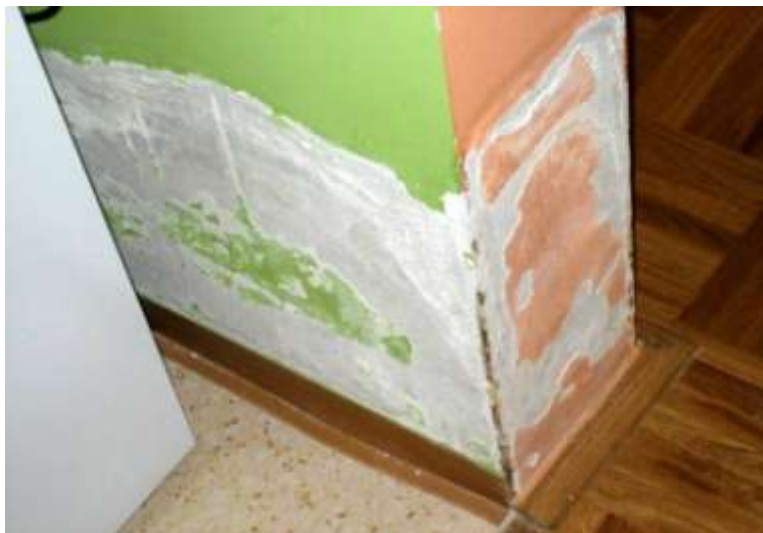
Poškodba opleska ter ometa zaradi poplave.
