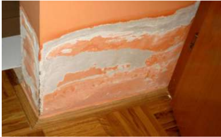
Poškodba opleska ter ometa zaradi poplave.
