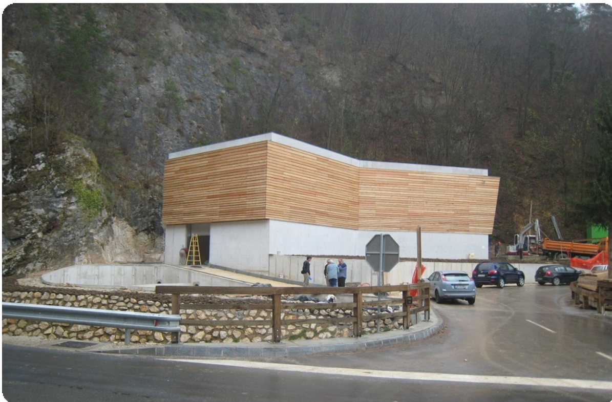
Slika 20: Vodarna Frankolovo 1 – v izgradnji (vir: arhiv Vodovod-kanalizacija d.o.o.)
