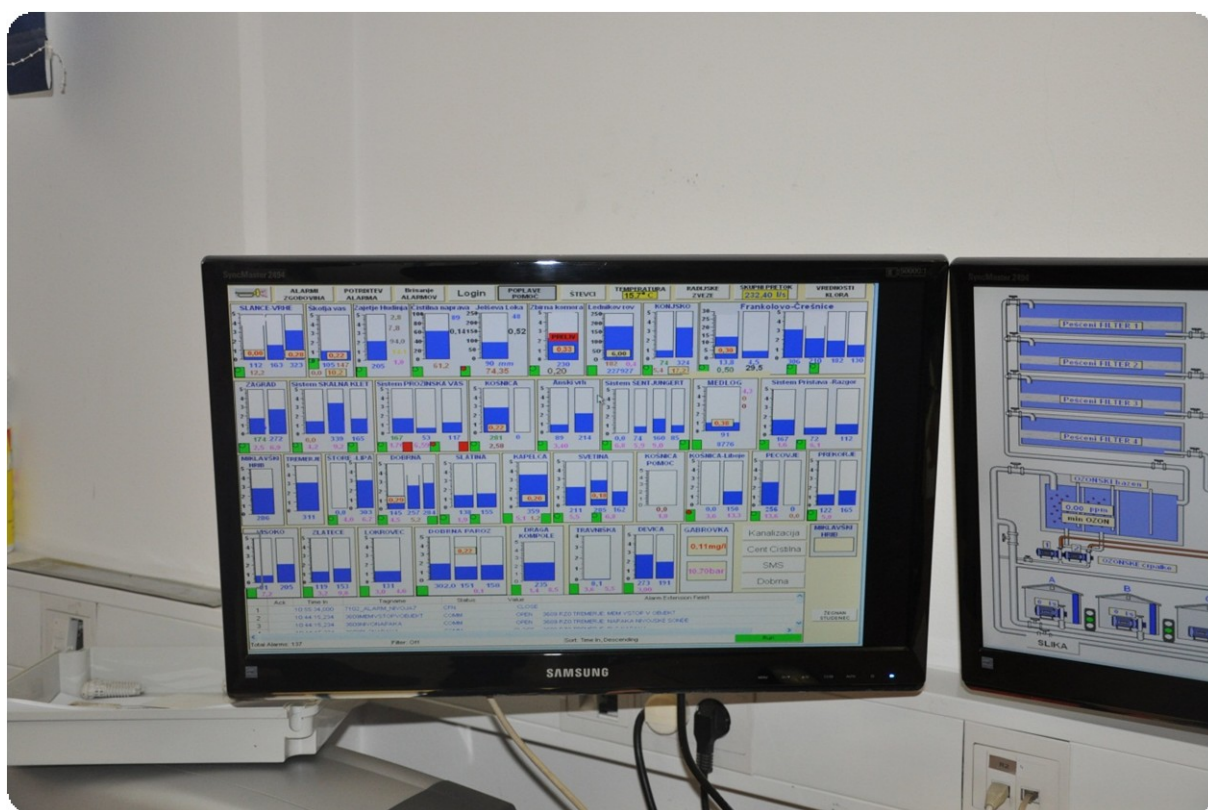
Slika 18: Monitoring – za nadzor vseh vodnih virov iz dispečerske postaje (VO-KA d.o.o.)
