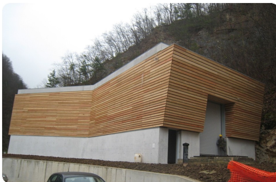
Slika 21: Vodarna Frankolovo 2 – v izgradnji (vir: arhiv Vodovod-kanalizacija d.o.o.)
