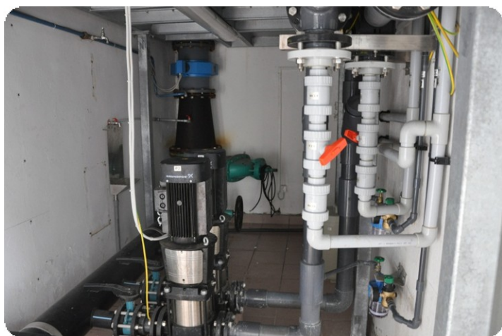
Slika 16: Naprava za ozonacijo (avtor: Matija Del Negro)
