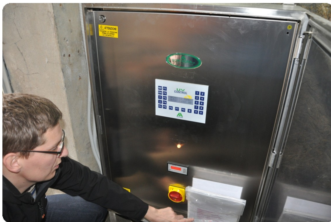
Slika 24: Računalnik za upravljanje naprave za UV dezinfekcijo (avtor: Matija Del Negro)
