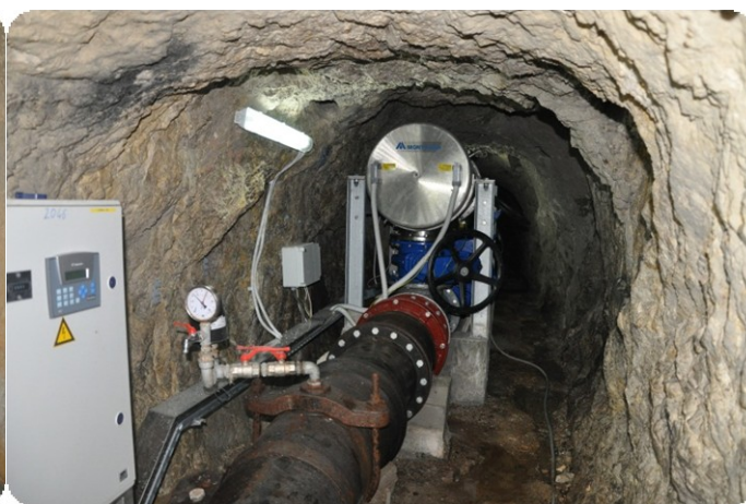
Slika 15: Naprava za UV dezinfekcijo (avtor: Matija Del Negro)
