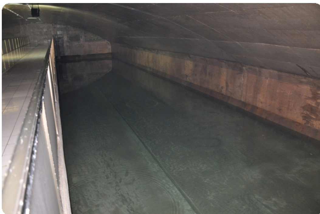
Slika 23: Vodohran Slance – notranjost (avtor: Matija Del Negro)
