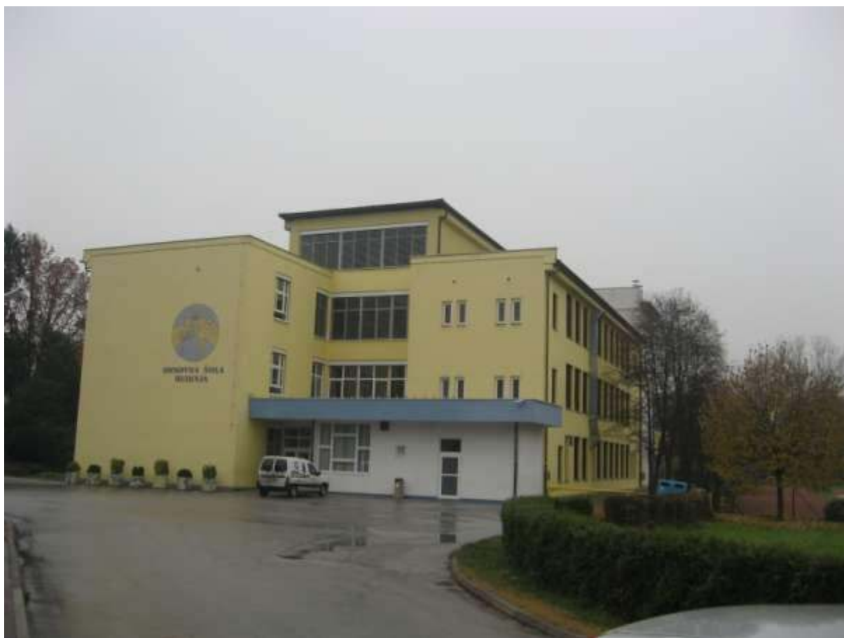
Slika 247: Pogled na Osnovno šolo Hudinja
