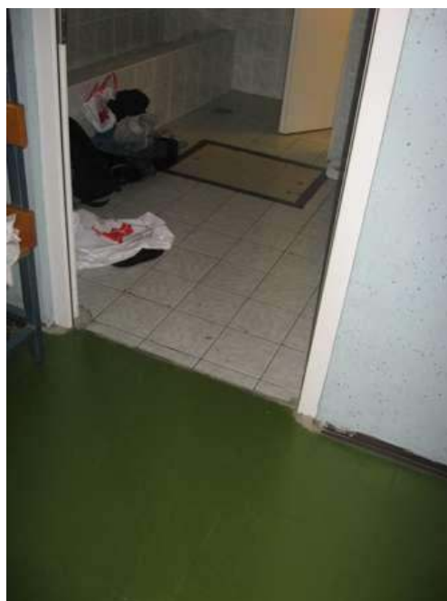
Slika 418: Vrata v sanitarije in garderobe
