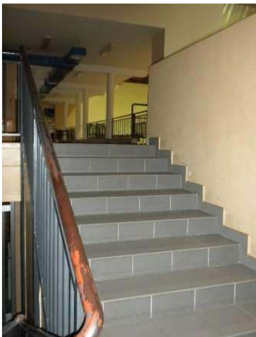
Slika 389: Stopnice, ki vodijo do sanitarij v novi telovadnici
