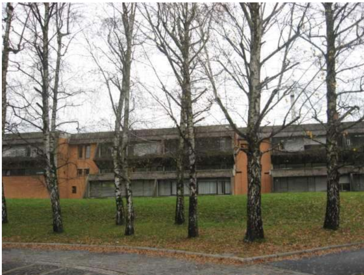
Slika 33: Pogled na II. Osnovno šolo Celje
