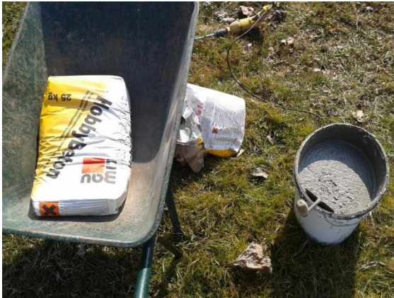
Slika 38: Priprava betona
