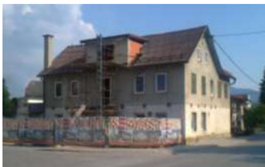
Slika 18: Prenova stanovanjskega objekta
