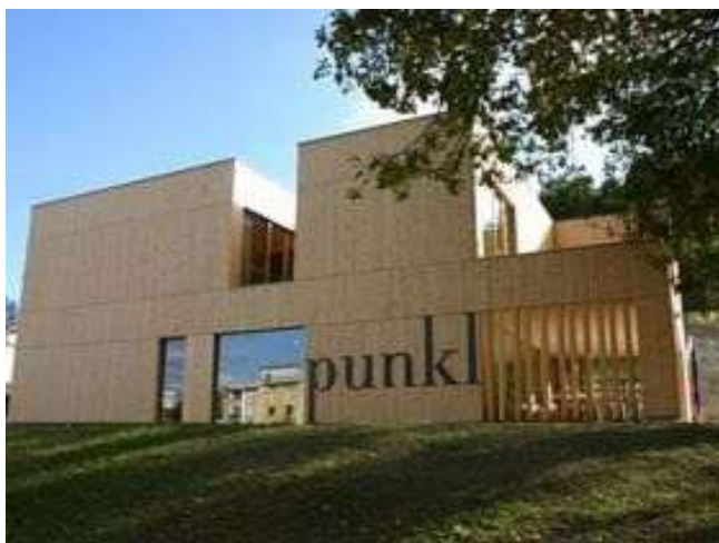
Slika 29: Punkl v Ravnah na Koroškem
