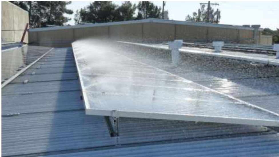
Slika 7: Primer čiščenja sončnih celic
