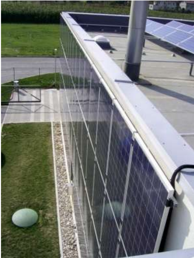
Slika 9: Fotonapetostna elektrarna na steni Energetike Vransko
