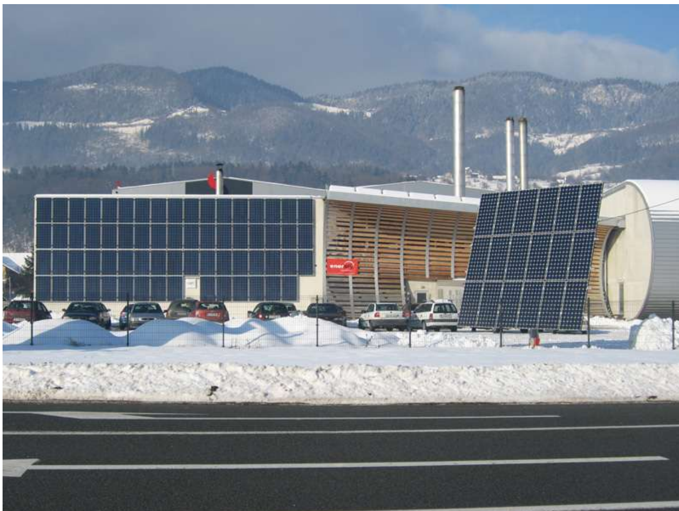
Slika 8: Fotonapetostna elektrarna Energetika Vransko
