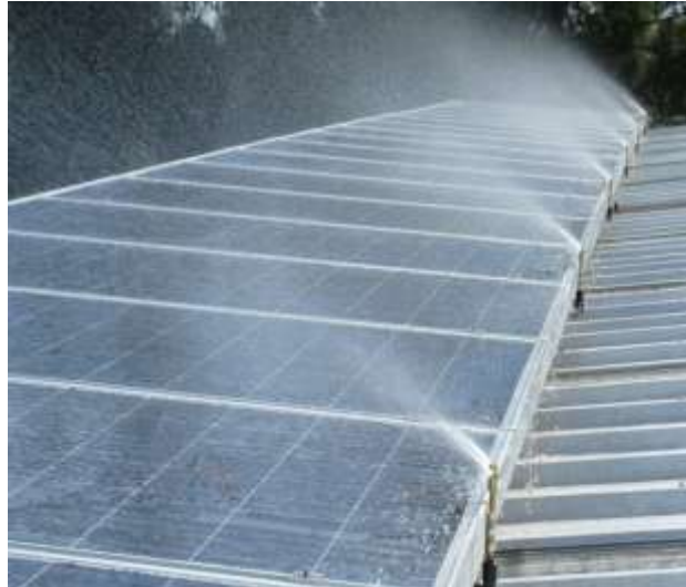
Slika 4: Primer čiščenja sončnih elektrarn
