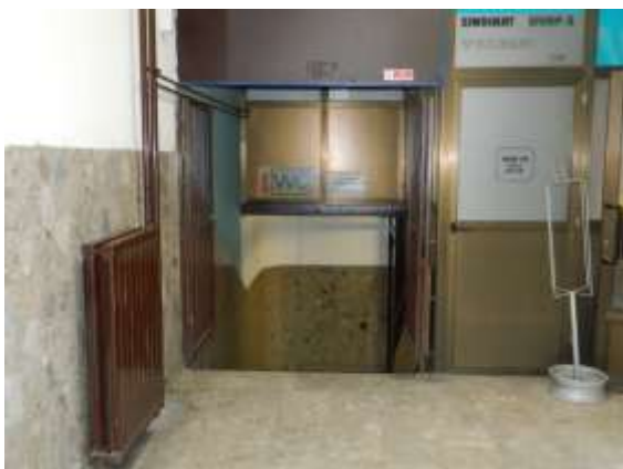
Slika 21: Vhod iz čakalnice v sanitarije od daleč
