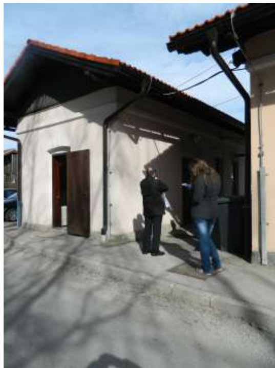
Slika 69: Ločena stavba sanitarij
