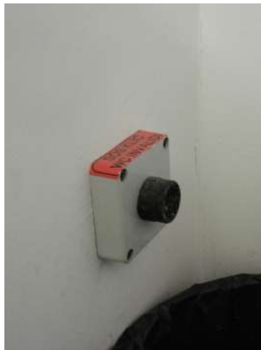
Slika 6: SOS klicna naprava v kabini za zaposlene
