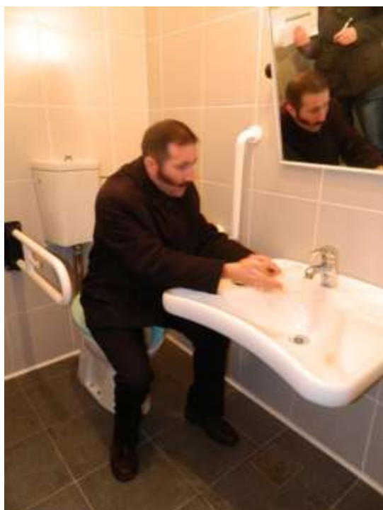
Slika 42: Primerno nameščena držala in višina umivalnika
