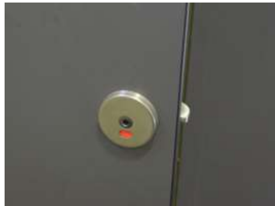
Slika 10: Nameščen mehanizem za zaklepanje
