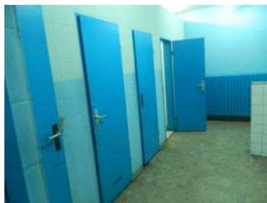
Slika 34: Pogled na moške sanitarije
