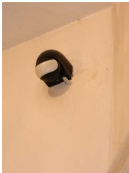
Slika 43: Senzor pri invalidih za prižiganje luči namesto stikal
