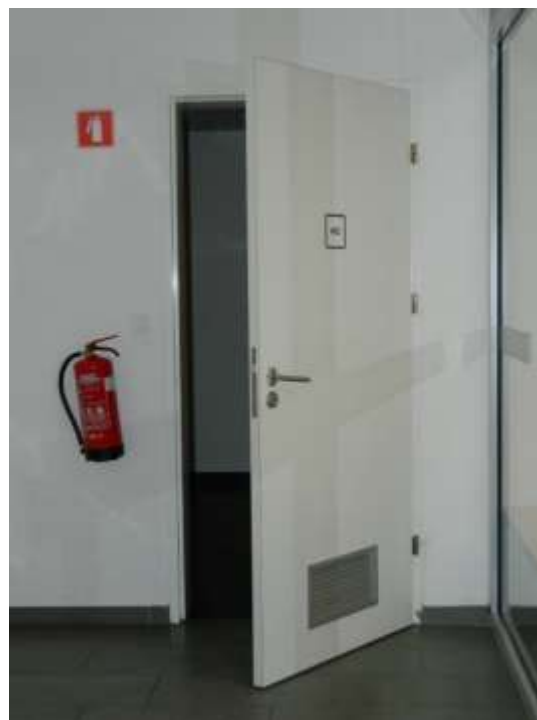
Slika 60: Vrata z režo za zračenje in oznako sanitarij
