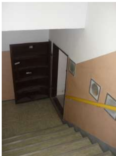
Slika 25: Vhodna vrata v zaklonišče
