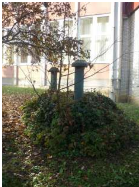
Slika 45: Zasilni izhod iz zaklonišča
