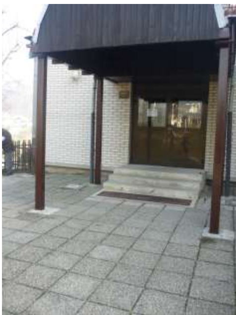
Slika 44: Vhod v prizidek šole
