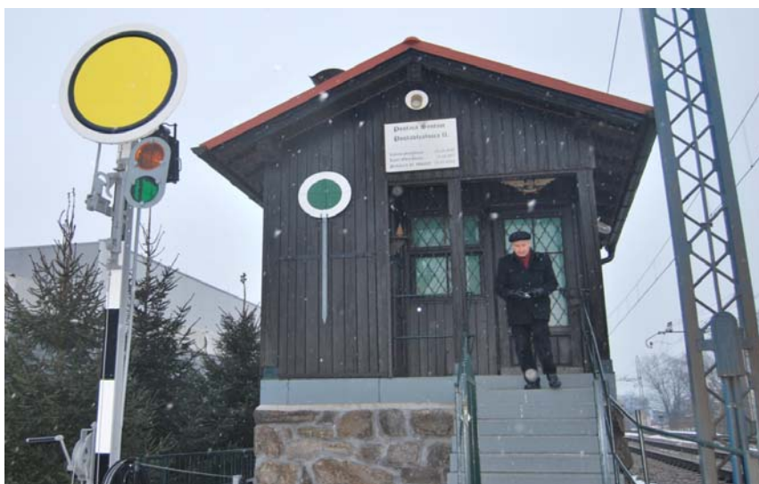
Slika 56: Postavljalnica z nekdanjim glavnim signalom ob progi (Foto: Golob, 2013)
