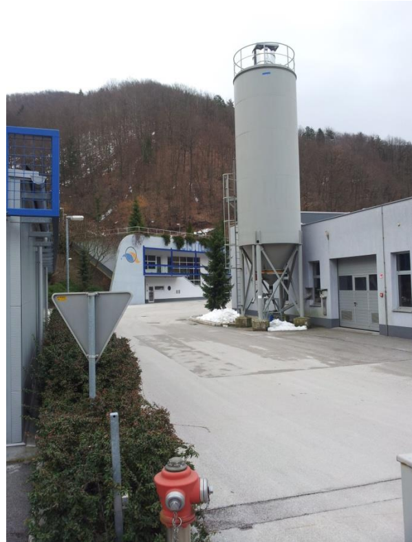
Slika 6: Čistilna naprava Celje
