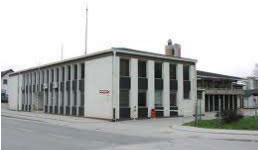
Slika 19: Gasilski dom Celje
