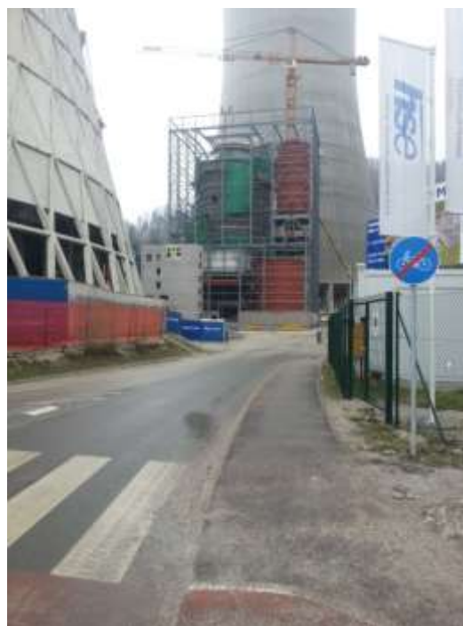
Slika 70: gradnja čistilne naprave
