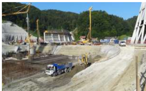
Slika 28: začetek graditve kotlovnice
