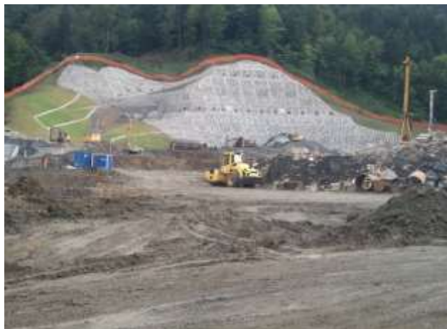
Slika 8: priprave na gradnjo, utrjevanje brežin
