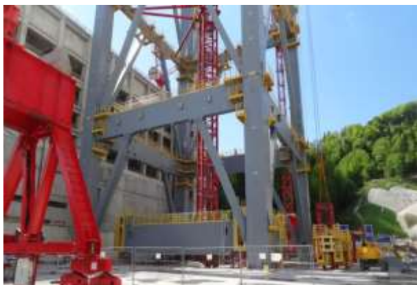
Slika 53: jeklena konstrukcija za kotlovnico
