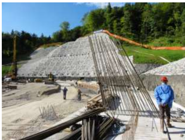
Slika 16: priključna armatura za stebre
