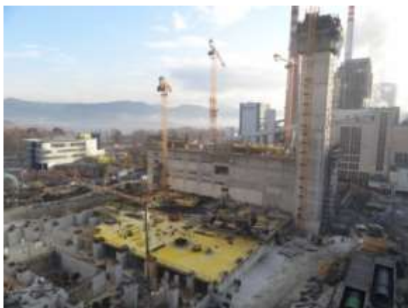
Slika 52: pogled na gradbišče
