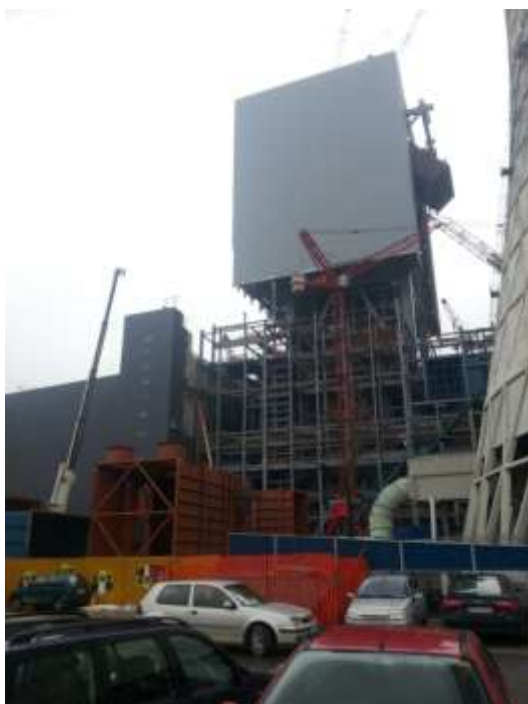
Slika 69: bunker in kotlovnica
