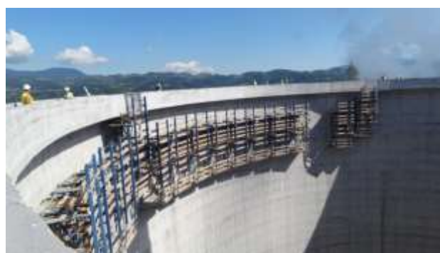
Slika 58: deli opaža na hladilnem stolpu
