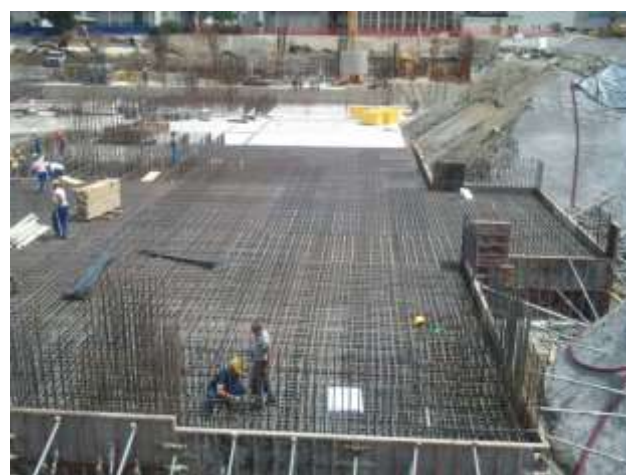
Slika 19: armaturne mreže temeljne plošče na GTO
