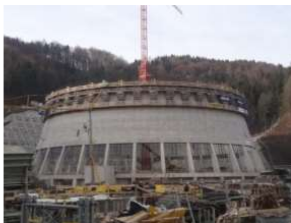
Slika 51: gradnja hladilnega stolpa
