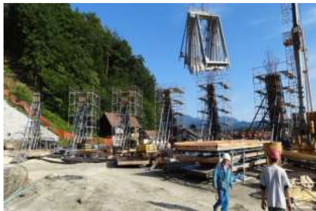
Slika 21: graditev podpornih stebrov
