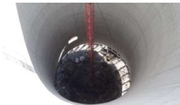
Slika 55: pogled iz vrha hladilnega stolpa
