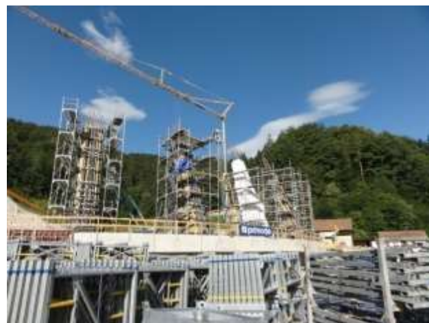
Slika 17: začetek gradnje hladilnega stolpa
