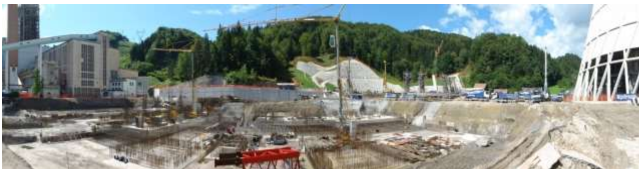
Slika 26: pogled na gradbišče poleti 2011
