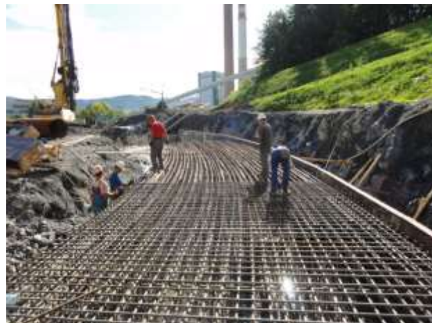
Slika 15: vstavljanje armaturnih mrež
