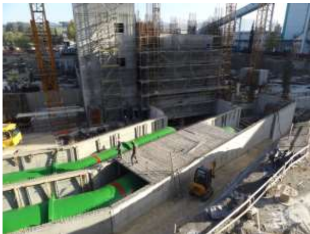
Slika 38: cevi za dovoz materialov
