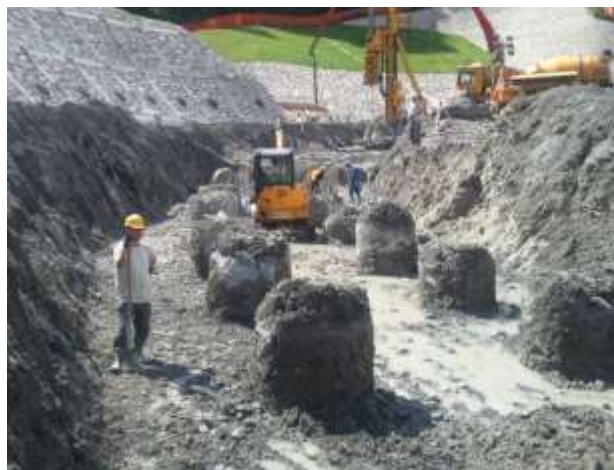
Slika 11: glave betonskih pilotov
