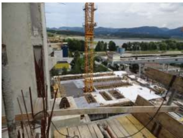
Slika 65: betoniranje strojnice
