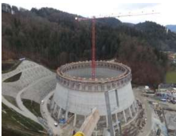
Slika 50: gradnja hladilnega stolpa
