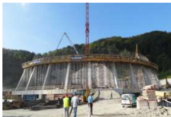
Slika 29: graditev prve etaže hladilnega stolpa
