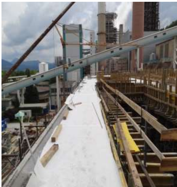
Slika 63: opaz strojnice
