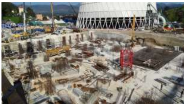
Slika 33: dokončani temelji za kotlovnico
