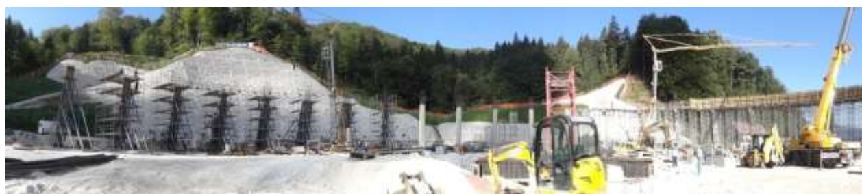
Slika 30: panoramska slika gradnje hladilnega stolpa
