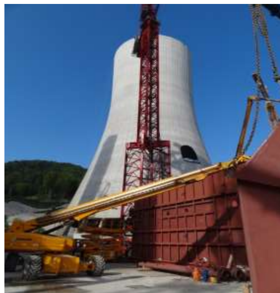
Slika 60: hladilni stolp v celoti
