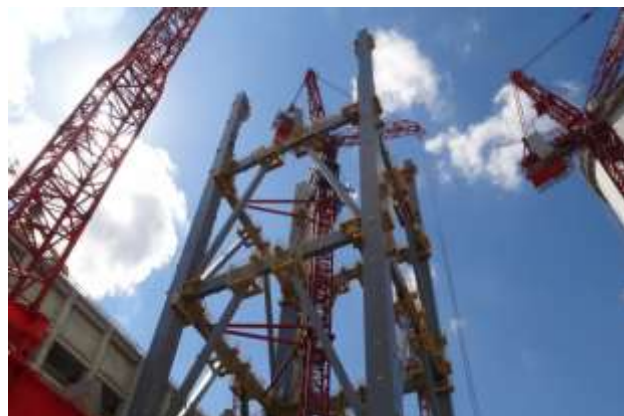
Slika 54: jeklena konstrukcija za kotlovnico
