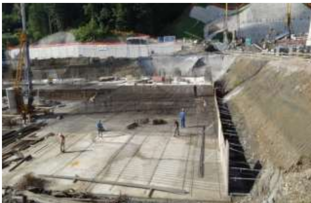
Slika 20: izdelava temeljne plošče
