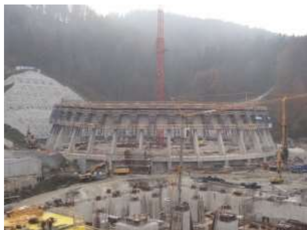
Slika 45: tretja etaža hladilnega stolpa
