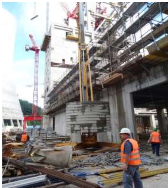
Slika 64: spodnji del bunkerja
