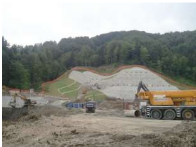
Slika 12: priprave na gradnjo
