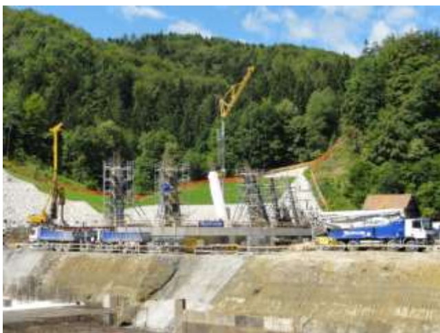
Slika 24: odstranjevanje opaža
