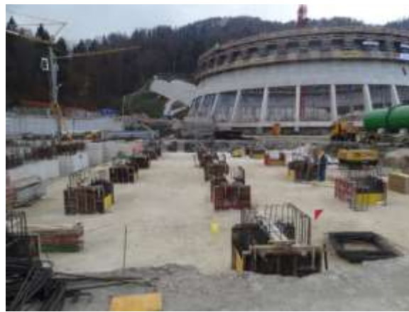
Slika 49: priprave na betoniranje temeljne plošče
