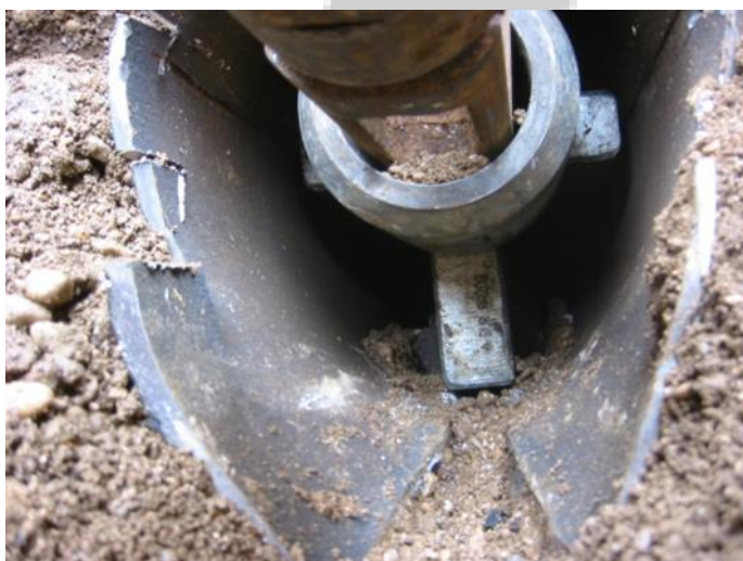
Slika 41: Prikaz rezanja kovinske cevi
