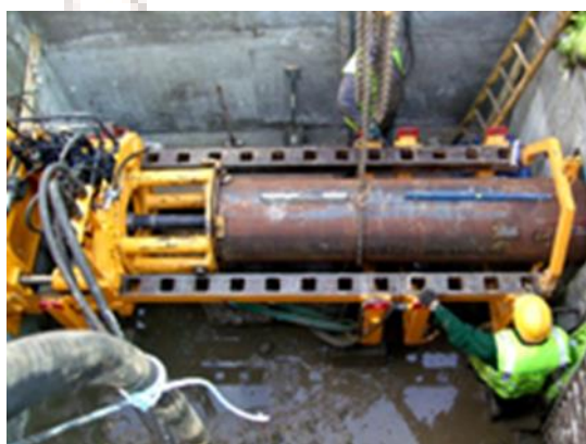
Slika 5: Potiskanje zaščitne kovinske cevi
