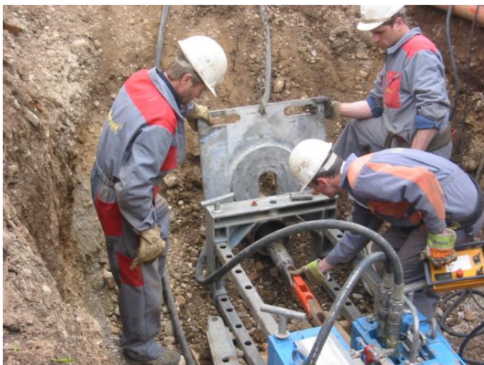
Slika 40: Prikaz v gradbeni jami
