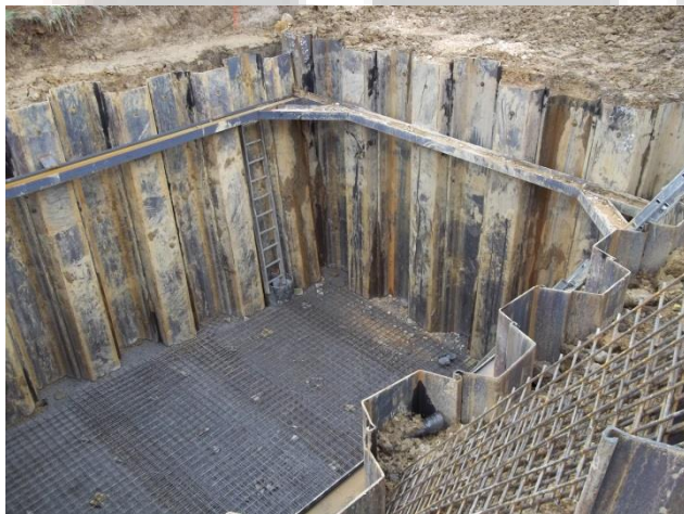
Slika 24: Prikaz armature
