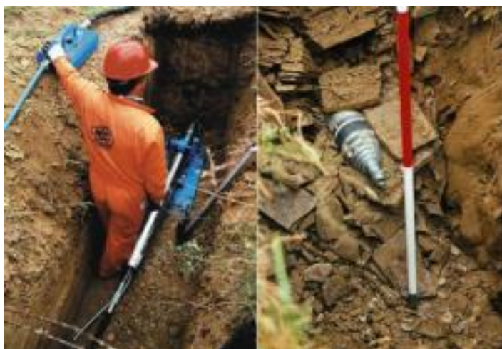
Slika 9: Prikaz vstopne in izstopne gradbene jame
