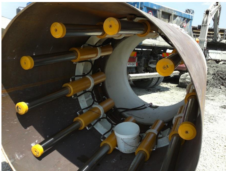
Slika 35: Vmesni cilindri (interjacki)
