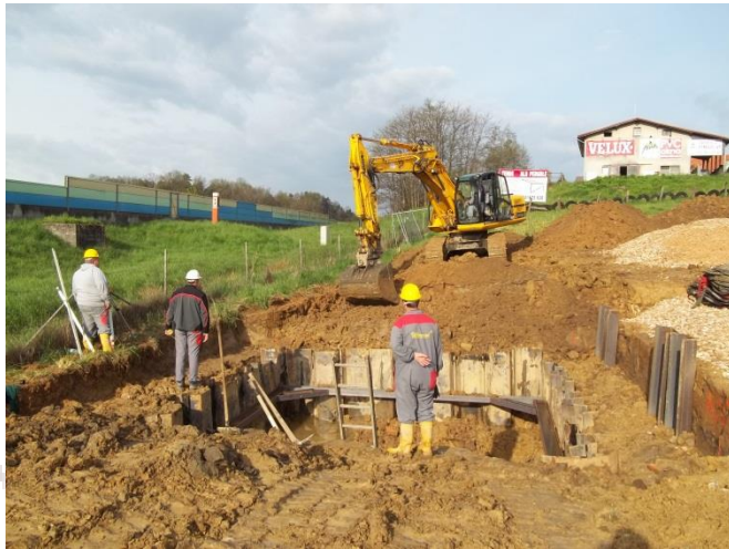
Slika 23: Priprava gradbene jame
