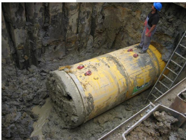
Slika 36: Izstop vrtalne glave iz vrtine
