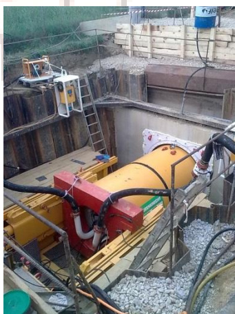
Slika 28: Prikaz potiska glave v zemljinu
