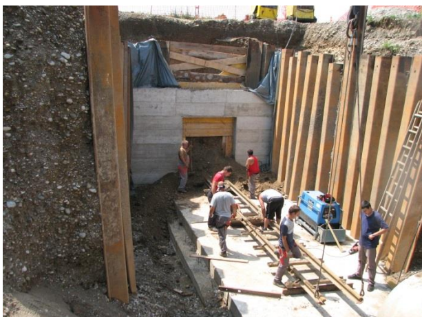
Slika 11: Priprava gradbene jame
