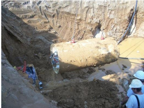
Slika 37: Odstranitev vrtalne glave
