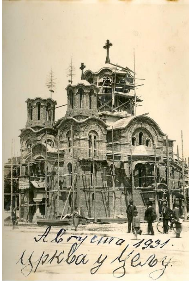
Slika 5: Gradnja cerkve sv. Save v Celju (Vir: Zgodovinski arhiv Celje, fond Cerkev sv. Save v Celju, 7-1)
