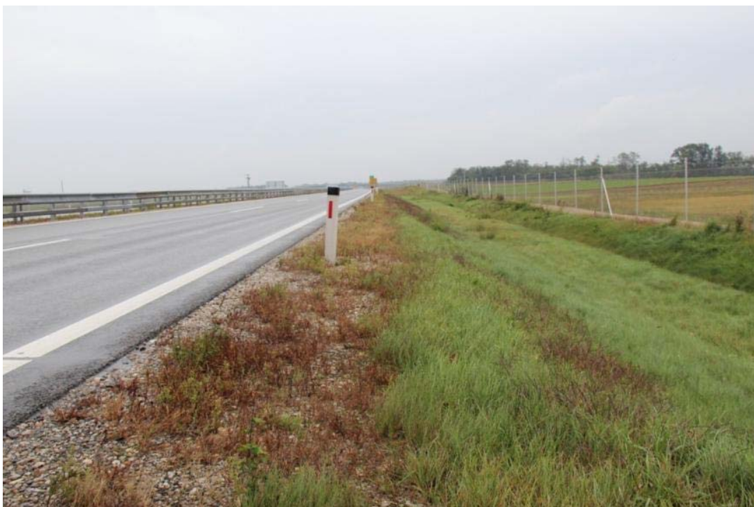
Slika 10: Pomanjkanje varnostne ograje na avtocesti oz. hitri cesti A5
