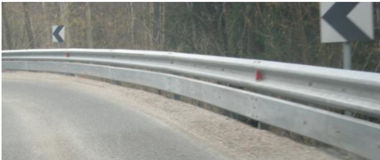
Slika 46: Dodatna varnostna ograja v levem zavoju
