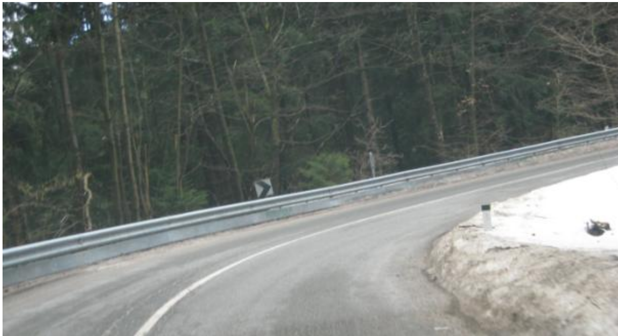
Slika 45: Dodatna varnostna ograja v desnem zavoju
