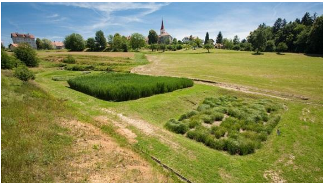
Slika 1: Rastlinska čistilna naprava v Sv. Tomažu. Vir: Vrhovšek in Vovk Korže, 2009.
