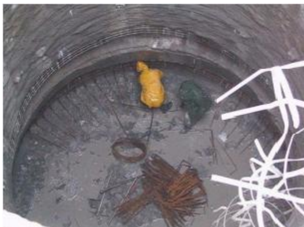
Slika 16: Montaža armature primarne obloge vodnjaka
