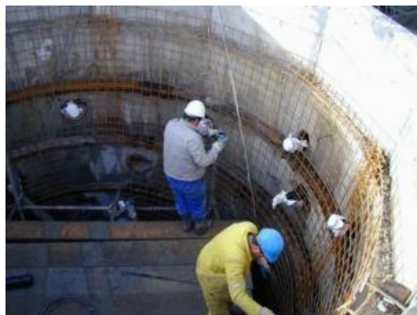
Slika 19: Ojačitev primarne obloge z armaturnimi mrežami, jeklenimi lokovi in brizganim betonom
