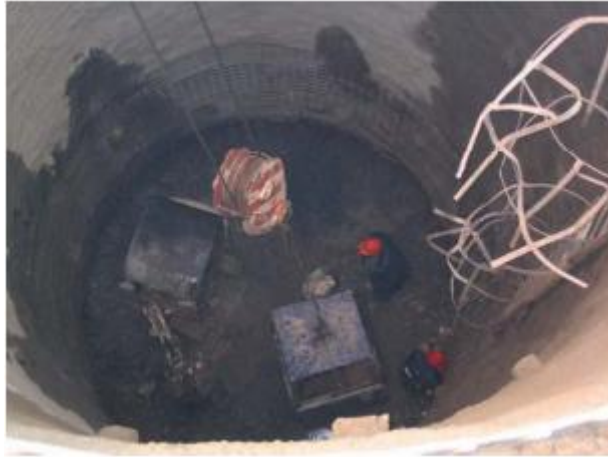
Slika 17: Poglabljanje izkopa vodnjaka za primarno oblogo
