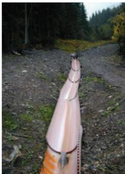
Slika 11: Odvodnja po polovičnih gibljivih ceveh
