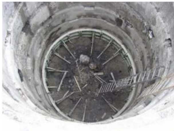
Slika 18: Opaženje primarne obloge vodnjaka
