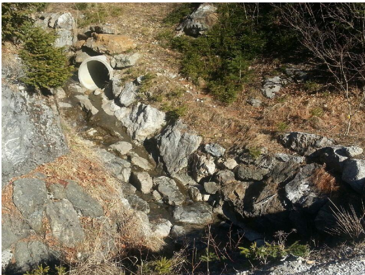
Slika 10: Površinska odvodnja na Macesnikovem plazu
