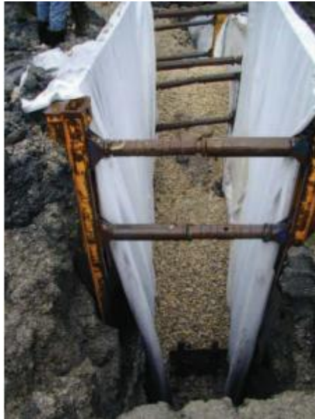
Slika 9: Izvedba globokih drenaž
