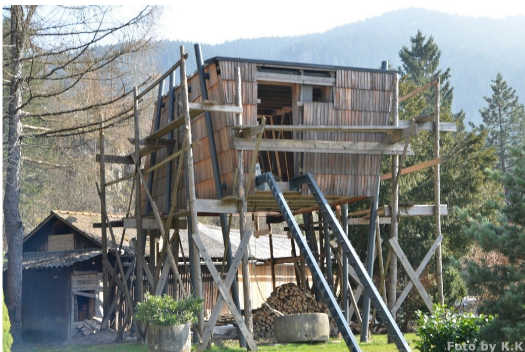
Slika 80: Graditev nove hiše Raduha
