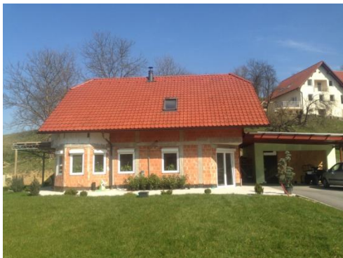
Slika 6: objekt 2, fasada jug, vir: lasten
