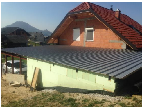
Slika 8: objekt 2, fasada vzhod, vir: lasten
