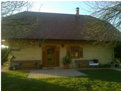
Slika 4: objekt 1, fasada vzhod, vir: lasten
