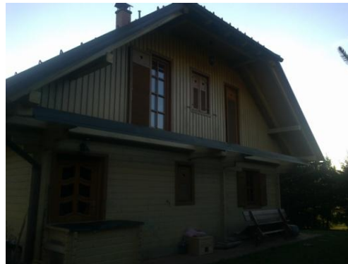
Slika 5: objekt 1, fasada sever, vir: lasten
