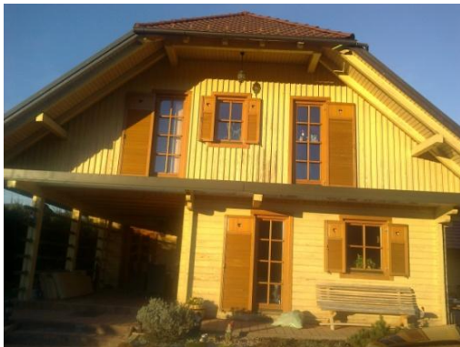
Slika 2: objekt 1, fasada jug, vir: lasten
