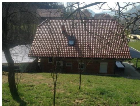
Slika 9: objekt 2, fasada sever, vir: lasten
