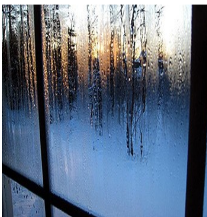
Slika 38: kondenz na steklu
