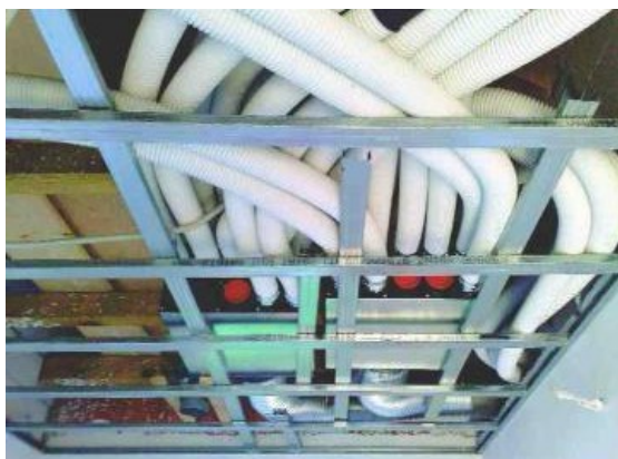
Slika 33: cevi za prezračevanje pod stropom
