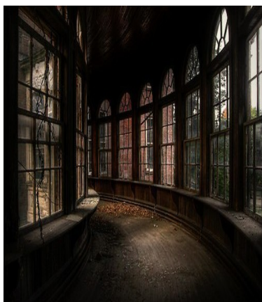
Slika 37: hodnik v stari stavbi
