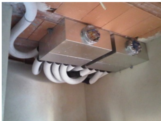
Slika 45: izmenjevalnik toplote
