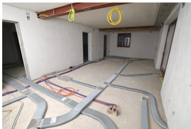
Slika 32: cevi v tleh pred vgradnjo estriha
