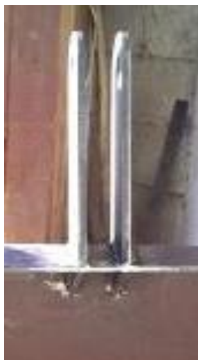
Slika 23: Zavarjeno vpetje poteznice
