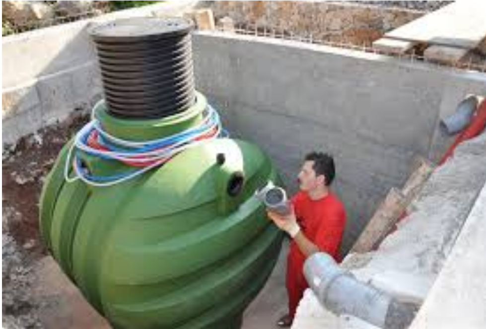
Fotografija 7. Mala komunalne čistilna naprava (armex-armature.si, 2010).
